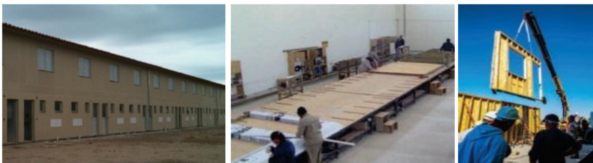
Figura 2: Residencial Haragano no canteiro de obras e na fábrica
