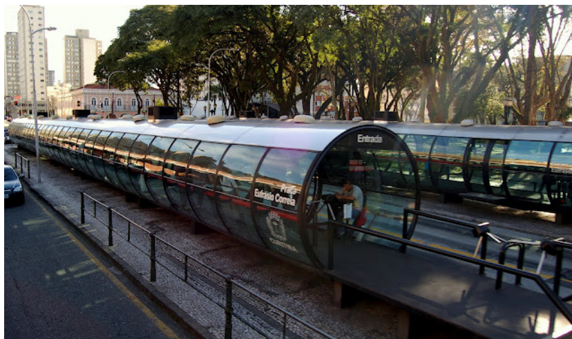
Figura 19. Estação Tubo Praça Eufrásio Corrêa.
