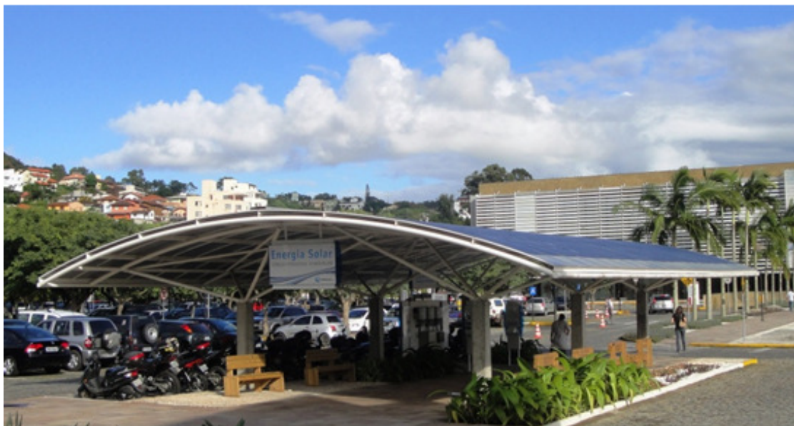
Figura 5. Uso de placas fotovoltaicas curvas em silício amorfo. (Eletrosul – SC)
