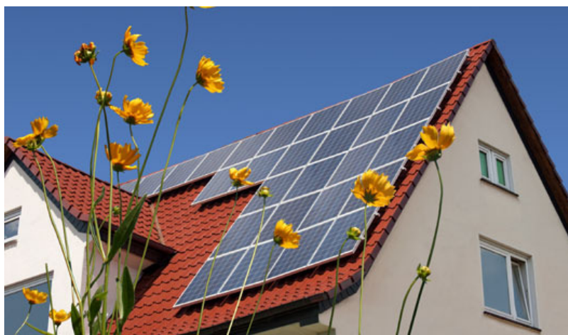
Figura 3. Uso de placas fotovoltaicas em silício policristalino em residência.
