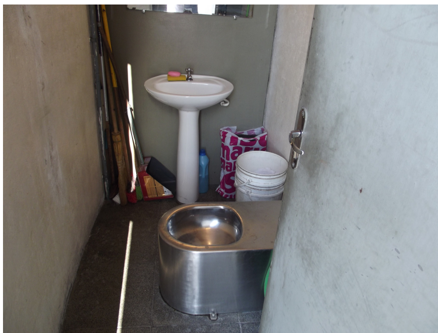
Figura 29. Vista interna do sanitário - Estação Tubo Santa Bernadethe. Fonte: Acervo do Autor – registrada em 11/08/2012.
