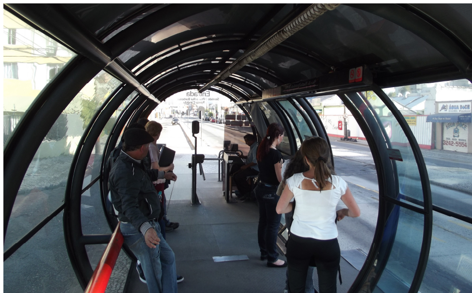
Figura 16. Vista interna Estação Tubo Dom Pedro I.
