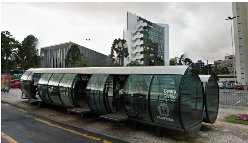
Figura 21. Estação Centro Cívico.
