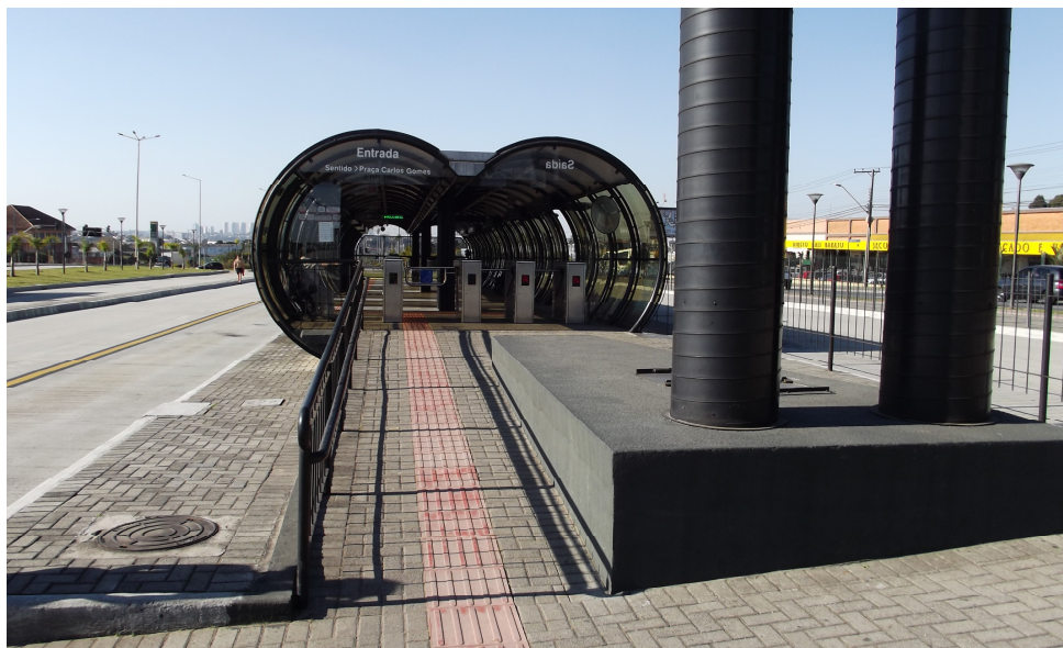
Figura 27. Acessibilidade através de rampas - Estação Tubo Santa Bernadethe.
