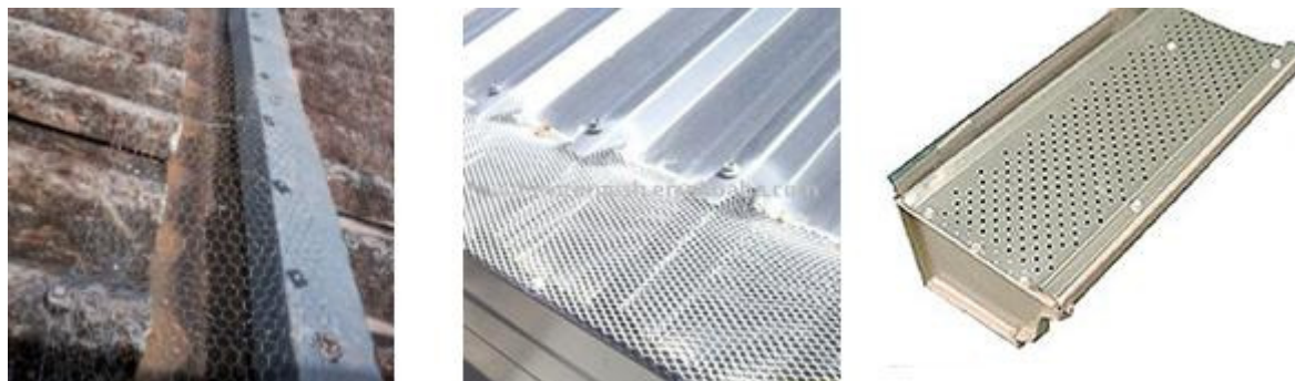
Figura 3 - Exemplos de calhas com telas de retenção de materiais grosseiros
