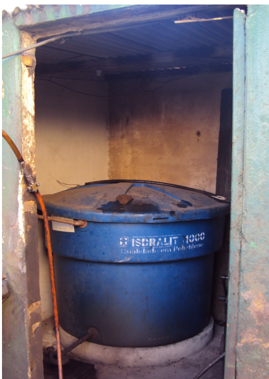
Fotografia 3 - Reservatório de água potável (lavagem de veículos) Fonte: Autoria própria
