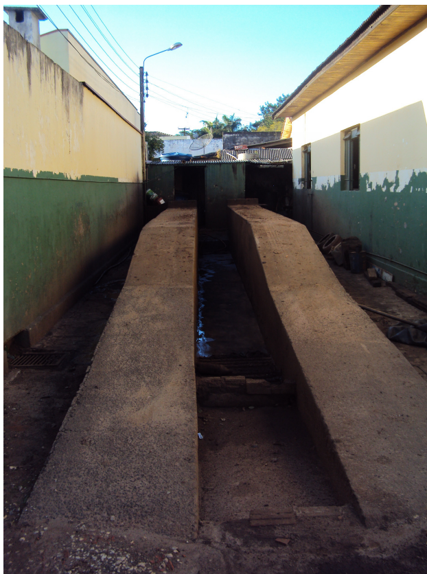
Fotografia 6 - Área de lavagem de veículos Fonte: Autoria própria
