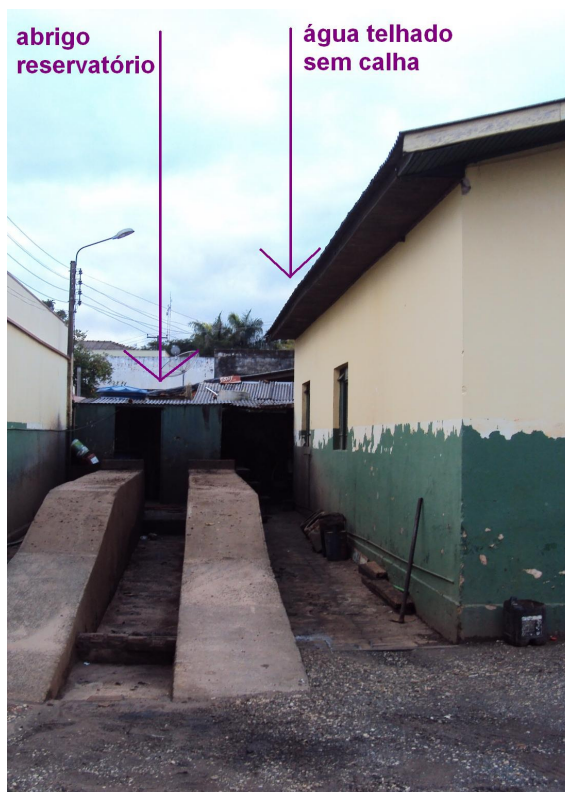
Fotografia 8 - Local de implantação reservatório Fonte: Autoria própria
