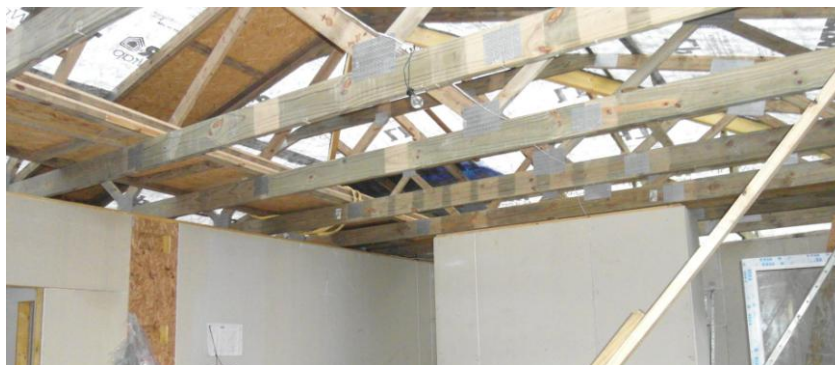
FIGURA 12 – ESTRUTURA COBERTURA Fonte: Memorial Descritivo – ECOSHAUS – 2010
