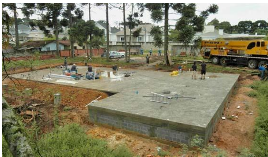
FIGURA 9 – LAJE RADIER Fonte: Memorial Descritivo – ECOSHAUS – 2010
