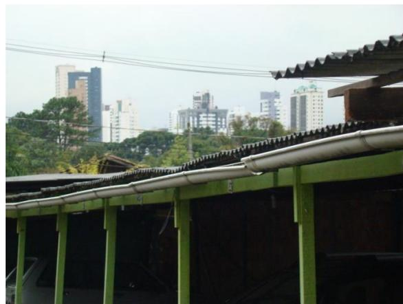
Figura 4 - Calhas para Condução de Águas de Chuva
