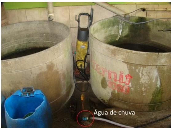
Figura 7 - Reservatórios Conectados ao Pressurizador
