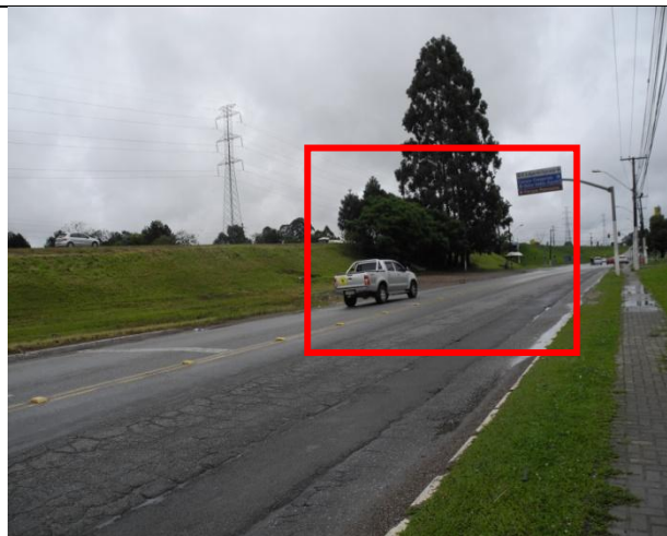
Desrespeito às normas de trânsito. Ponto de ônibus sem calçada para o pedestre.
