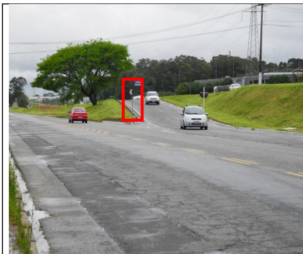
Falta sinalização vertical.
