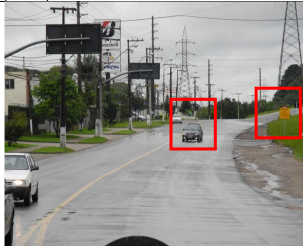
Desrespeito às normas de trânsito. Lateral da pista em péssimas condições. Sinalização encobrindo a outra
