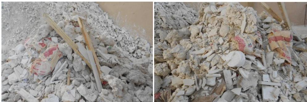
**Figura 04 - Processo de triagem – REC gesso**
