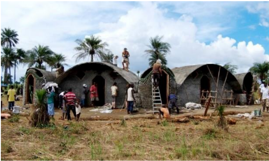
Figura 12: Centro comunitário em construção FONTE: ECOPENSAR (2016)
