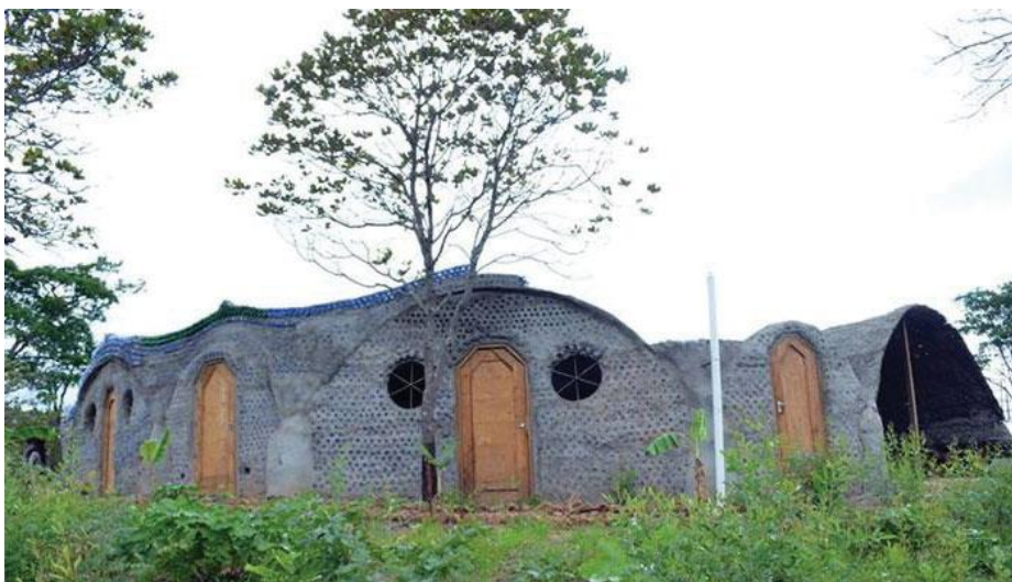
Figura 13: Edificação finalizada FONTE: CICLO VIVO (2016)
