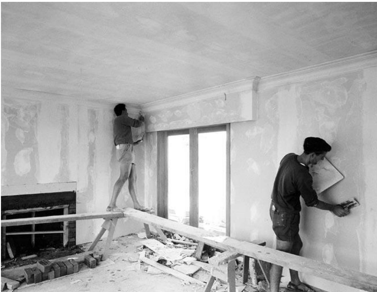
Figura 15. Utilização da placa de gesso acartonado como revestimento interno.
