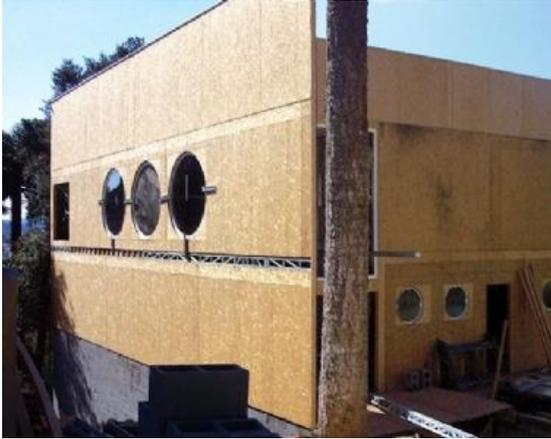
Figura 20. Construção com o sistema CES.
