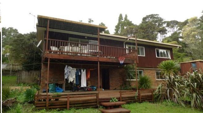
Figura 5. Edificação de dois pavimentos; térreo em alvenaria de tijolos e superior de madeira.
