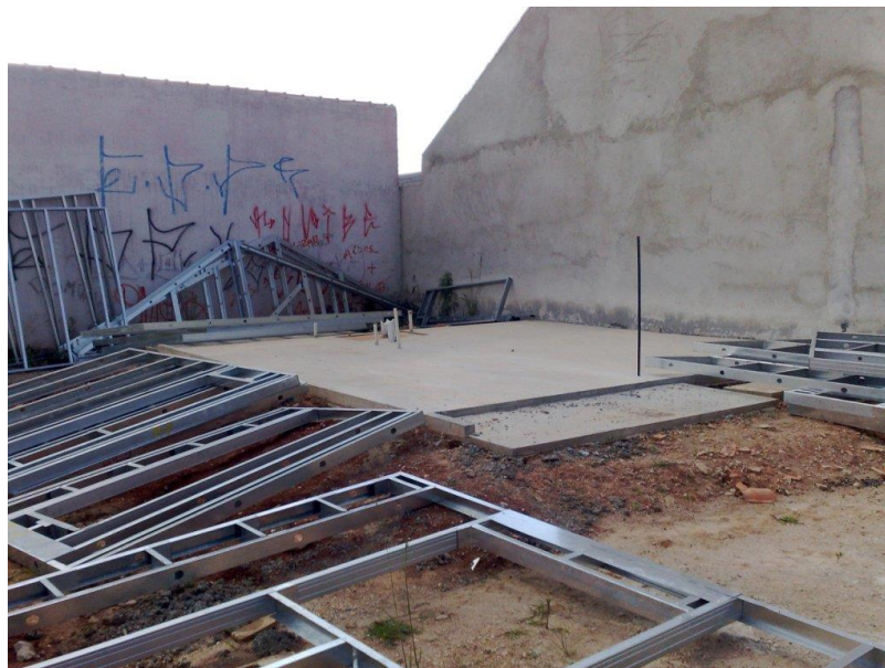
Figura 9: Montagem de edificação em steel frame Fonte: COHAB-CT, 2012.
