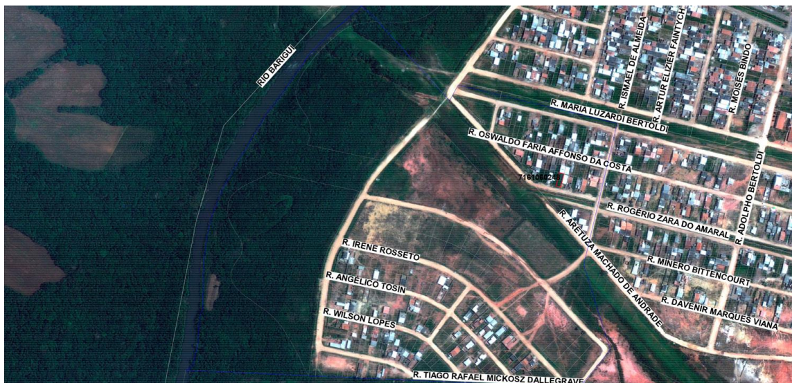
Figura 15: Foto parcial do empreendimento Moradias Rio Bonito Fonte: COHAB-CT.
