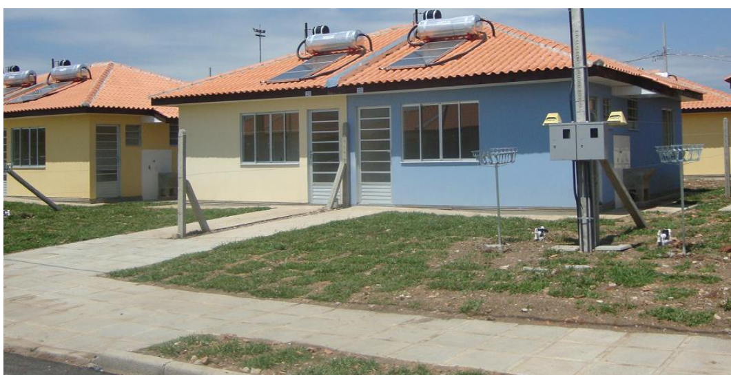
Figura 14: Edificação em wood frame Fonte: COHAB-CT.
