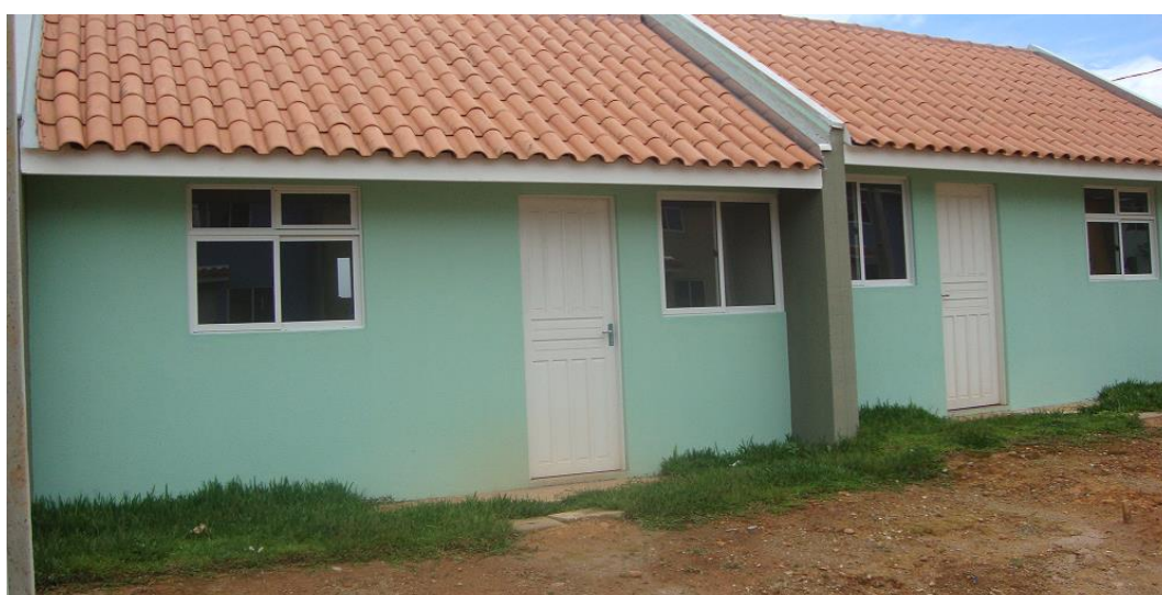
Figura 19: Unidades CT2-33 construídas em alvenaria Fonte: COHAB-CT.
