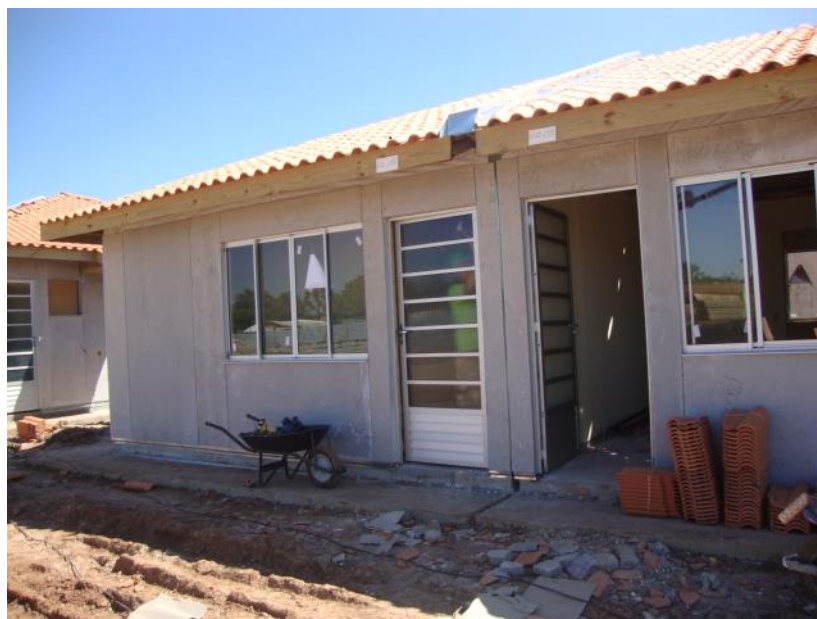
Figura 6: Construção de casa em wood frame Fonte: COHAB-CT, 2015.
