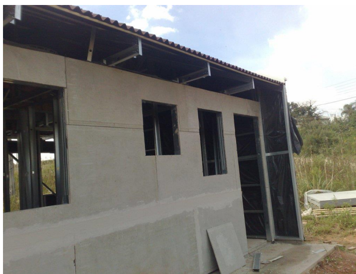
Figura 7: Construção em steel frame Fonte: COHAB-CT, 2012.
