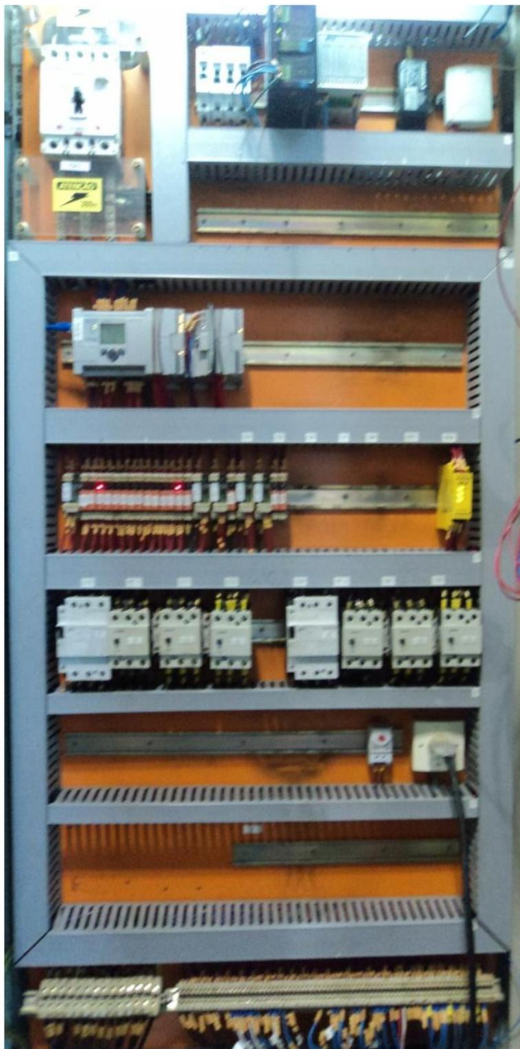
**Figura 68 – Painel de comando após a modificação**
