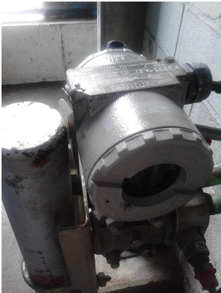
**Figura 8 – Transmissor indicador de vazão**
