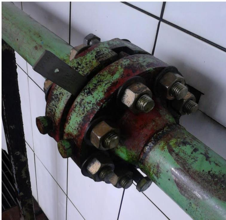
**Figura 9 – Montagem da placa de orifício**
