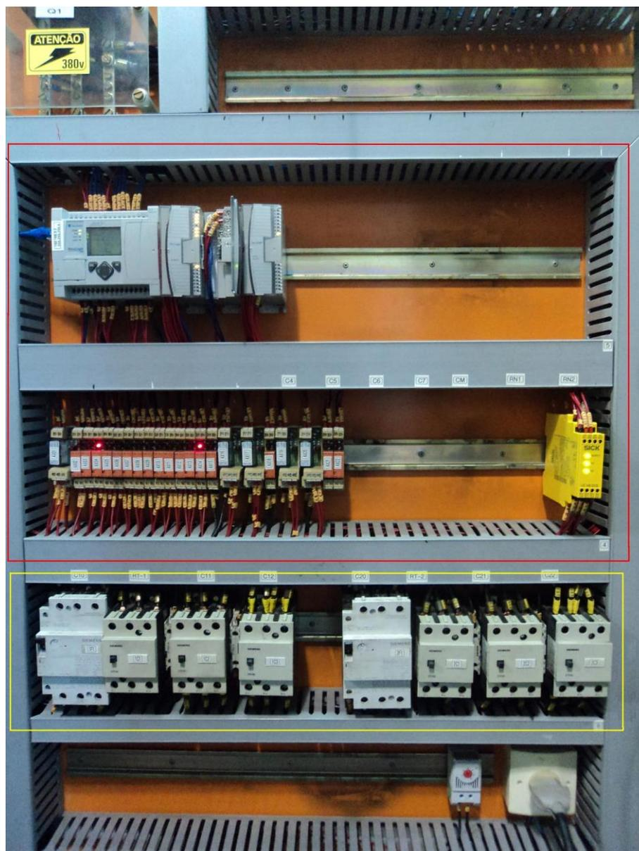
**Figura 71 – Disposição do painel de comando após a modificação**
