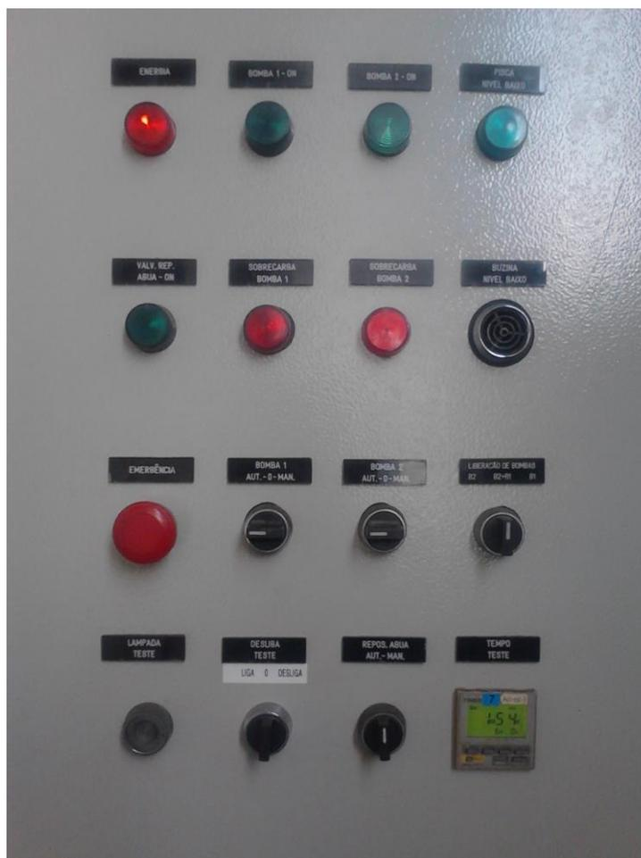
**Figura 16 – Painel de controle do sistema, detalhe da porta**
