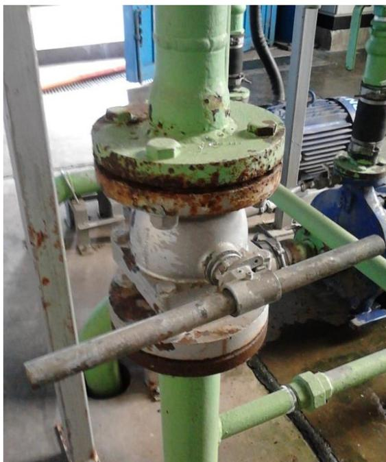
**Figura 76 – Válvula manual de retorno pro reservatório**
