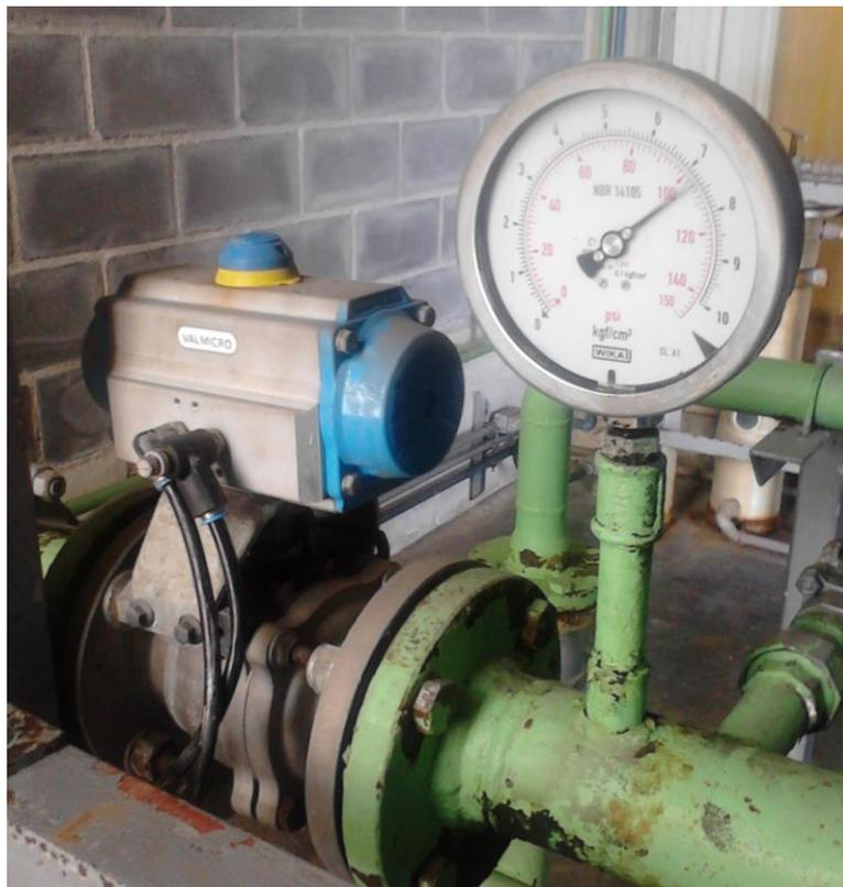
**Figura 11 – Válvula principal montada na tubulação**
