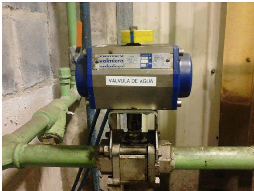
**Figura 12 – Válvula de reposição de água do reservatório**
