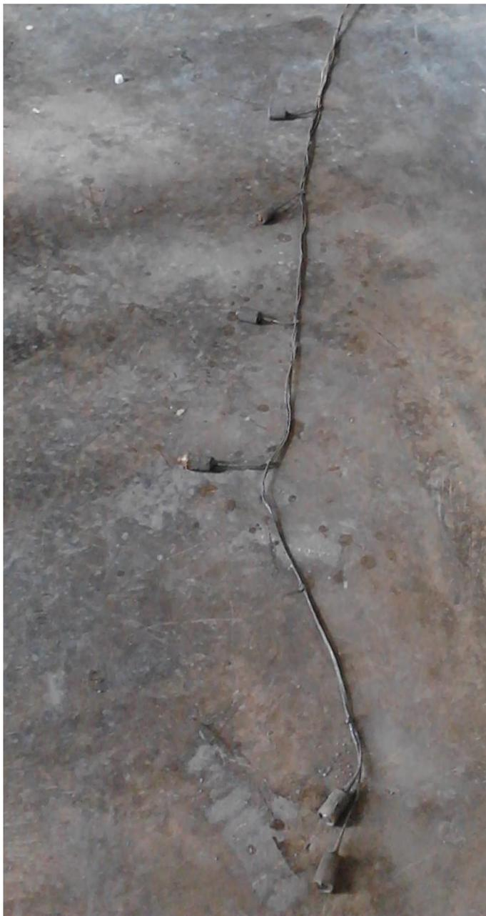
**Figura 7 – Eletrodos sensores de nível**
