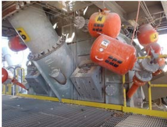
Figura 8 – Canhões de ar em torre de pré-aquecimento. Fonte: Martin (2013).
