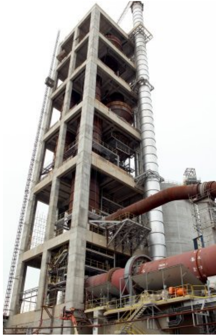
Figura 1 – Torre de Ciclones. Fonte: WEG (2011).
