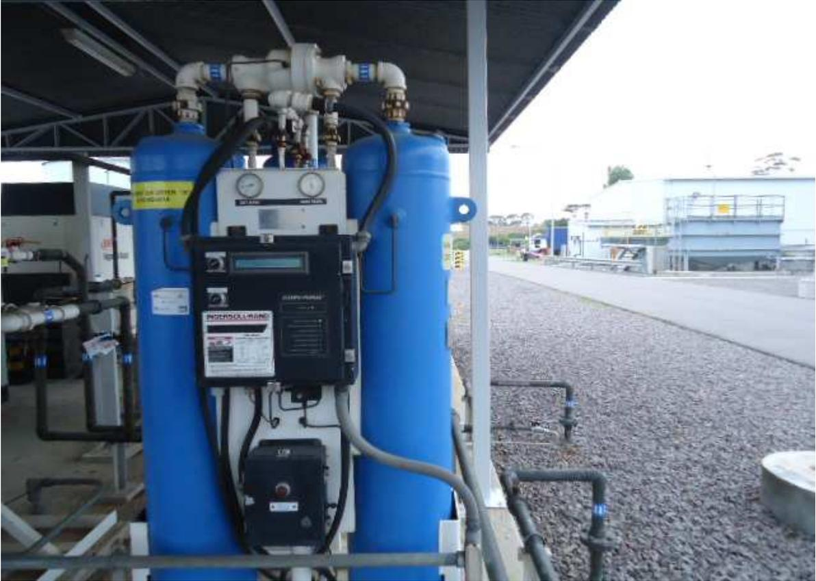
**Figura 20 - Torres de Secagem de Ar Comprimido e Controlador do Processo**
