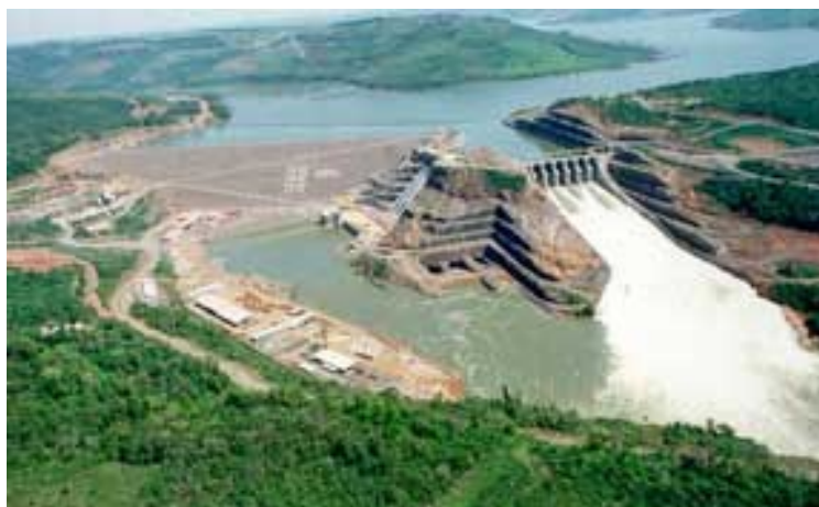
Figura 2 - Vista da UHE-GNB Fonte: Copel (2012)
