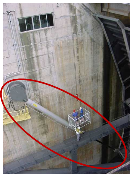
Figura 35 - Cilindro com a tecnologia Ceramax (UHE GJR) Fonte: Autoria própria
