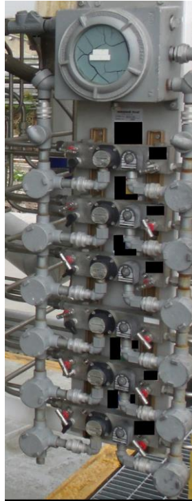
Figura 12 - Central de Controle de Aditivo FONTE: AUTORIA PRÓPRIA, 2015
