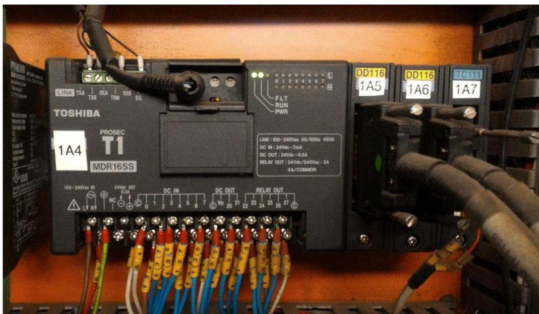
Figura 7 - CLP Toshiba PROSEC T1, instalado na máquina em projeto de reforma.
