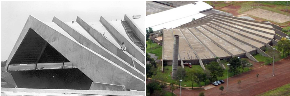
(a) Fase de Construção
