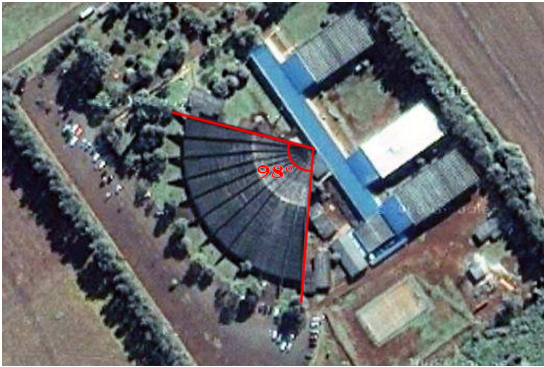
Figura 14: Vista aérea do Ginásio Belin Carolo (2003).
