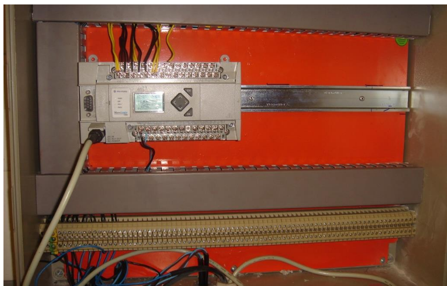
Figura 11. Painel com o CLP que realiza as leituras dos status das máquinas.
