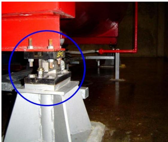
**Figura 7: Sensor de nível célula de carga**
