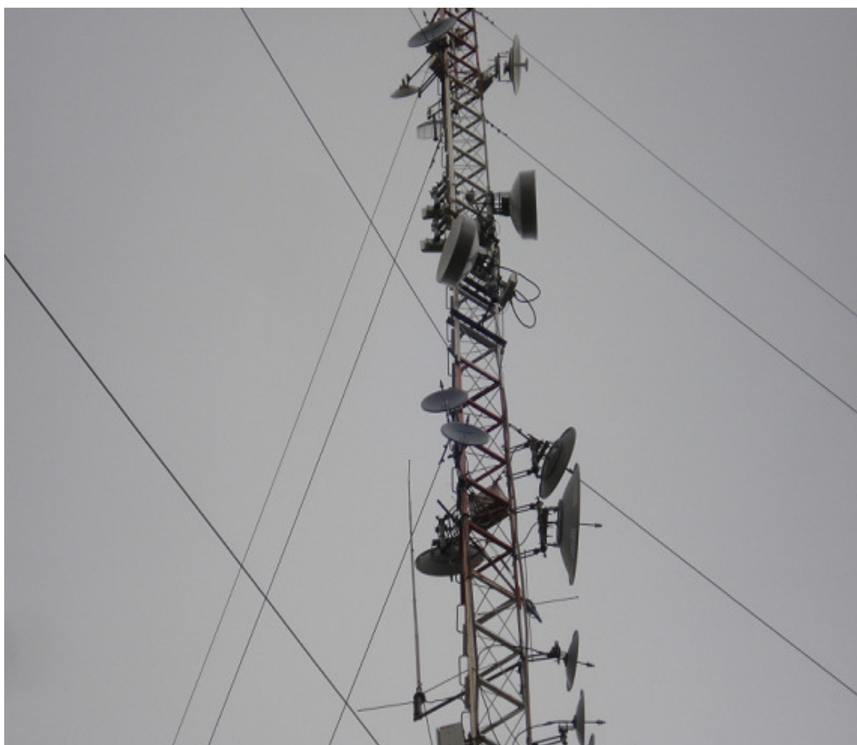
Fotografia 4 – Torre da base Morro do Carvalho Fonte: Autoria própria
