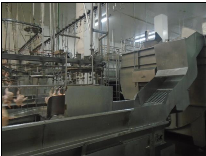
Figura 2 – Saída do chiller de pré-resfriamento das aves na linha de abate Fonte: Autoria própria.
