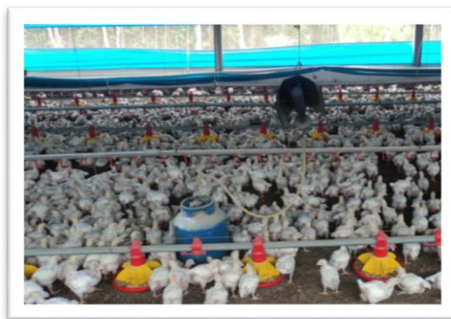
Figura 16: Sistema de Aquecimento do Aviário. Fonte: Aatoria própria (2014)
