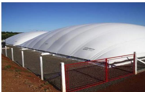
Figura 5: Biodigestor modelo canadense Fonte: HY Energia (2014).
