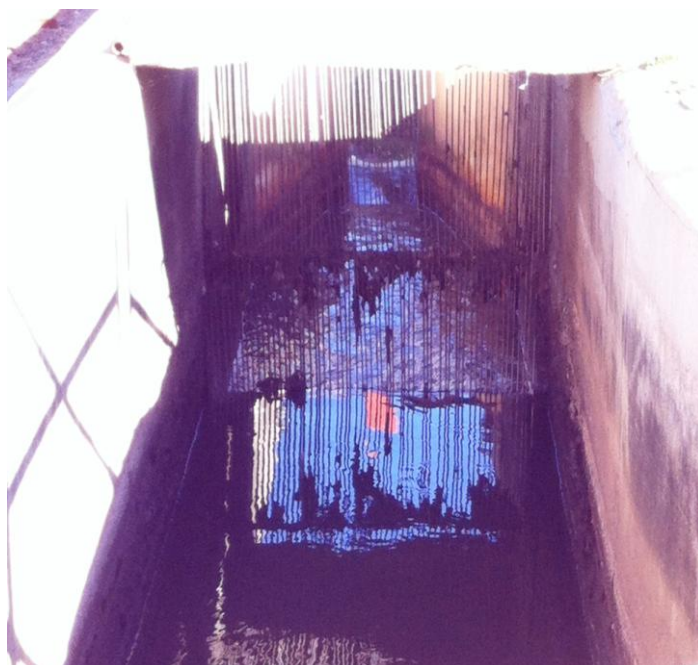
Fotografia 2 - Gradeamento Manual Secundário e Ponto de Amostragem 1 Fonte: Autoria própria (2014).
