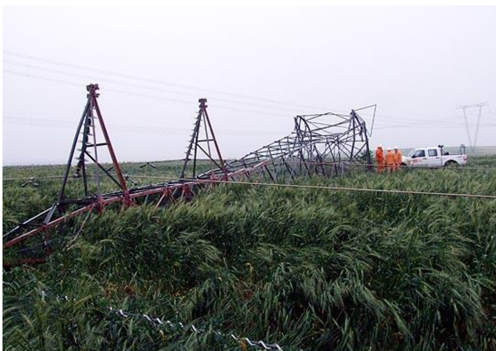
Figura 4 - ventos de até 116 km/h derrubam torres de transmissão no Paraná Fonte: Folha de S. Paulo, 2011
