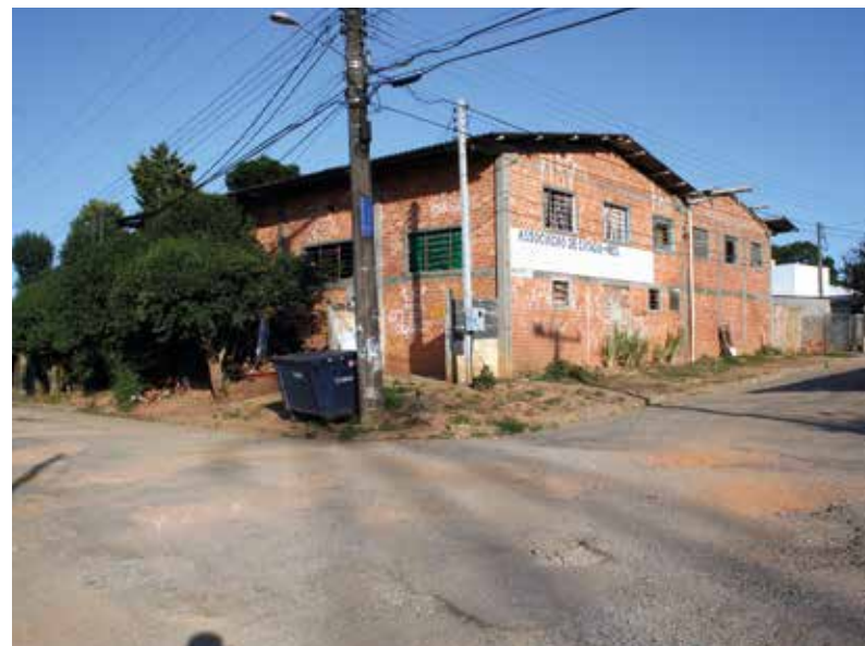
Figura 10 - Galpão da Associação de Catadores de Material Reciclável da Ilha Fonte: Autoria própria (2014).
