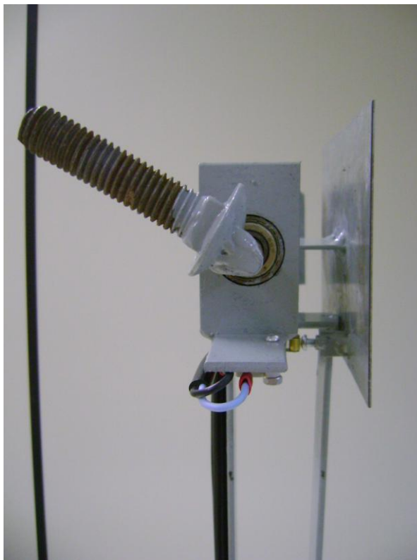
Fotografia 10 - Detalhe do contrapeso. Fonte: Autoria própria.
