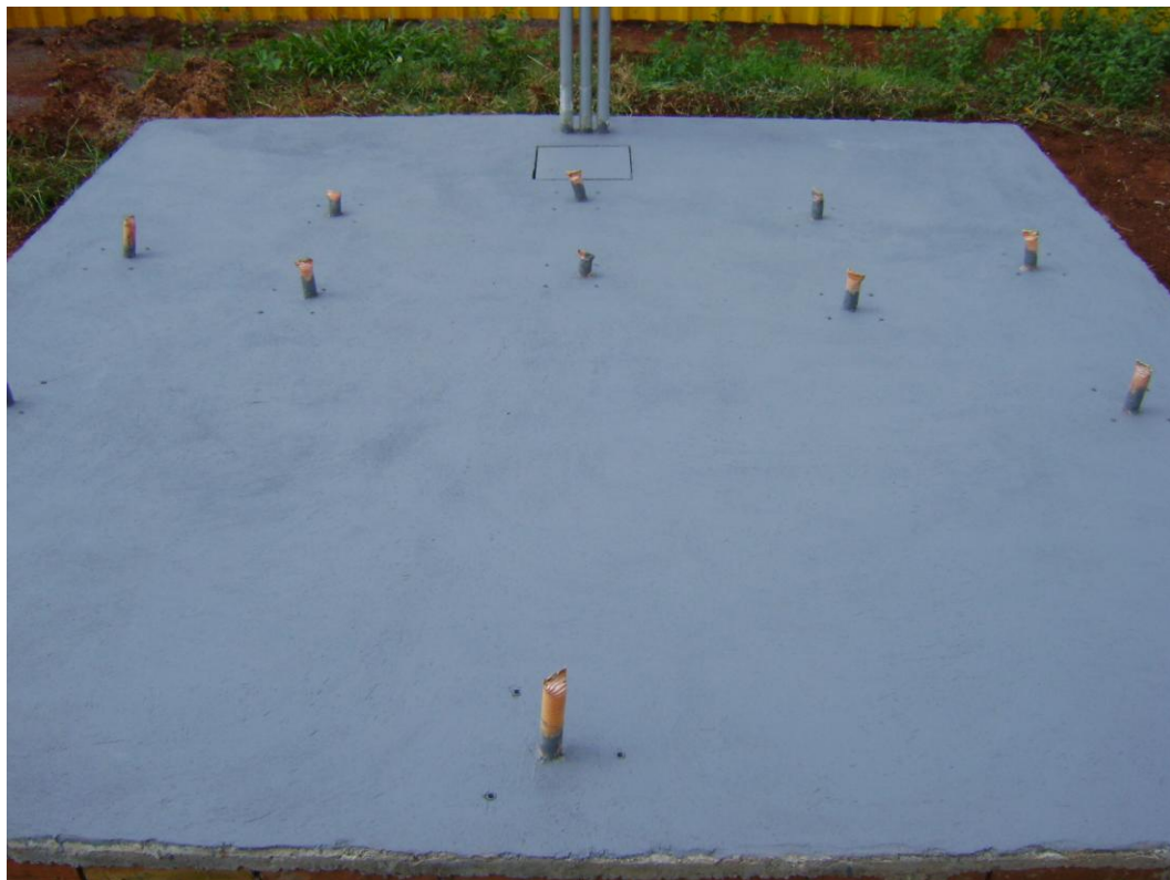
Fotografia 21 - Base finalizada. Fonte: Autoria própria.
