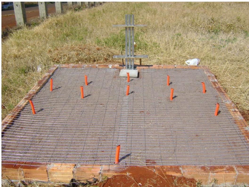
Fotografia 20 - Base em construção. Fonte: Autoria própria.
