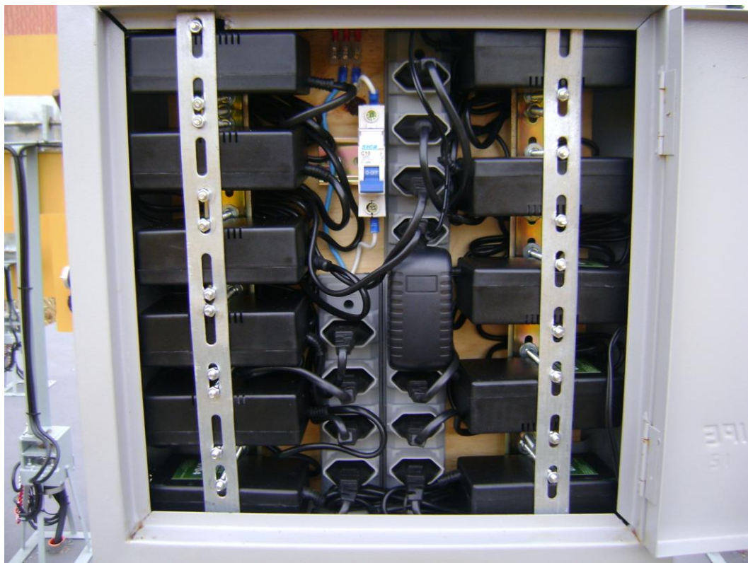
Fotografia 30 - Detalhe da caixa das fontes (40 x 40 x 12 cm). Fonte: Autoria própria.
