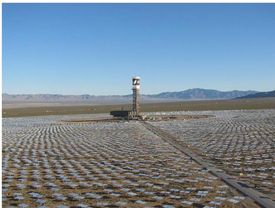
Fotografia 4 - Torre de potência de Ivanpah, Califórnia - EUA. Fonte: BrightSource Energy (2013).
