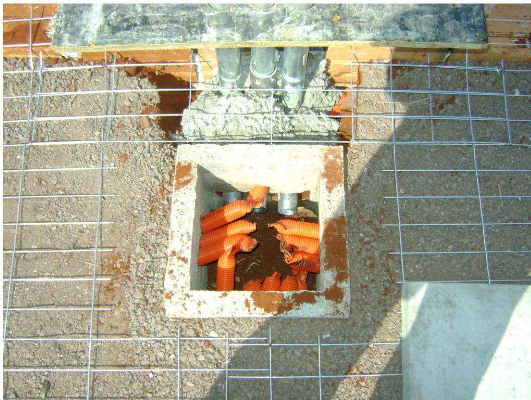
Fotografia 28 – Caixa de passagem antes da instalação. Fonte: Autoria própria.
