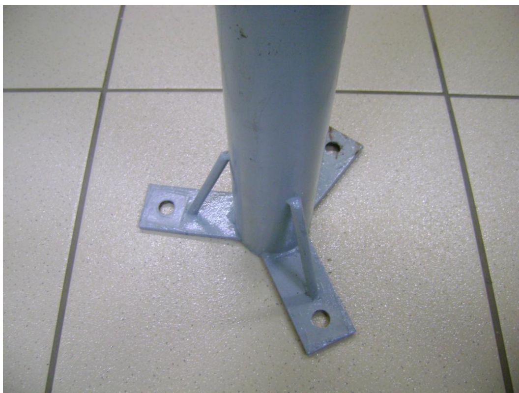
Fotografia 17 – Base da estrutura de sustentação da caldeira. Fonte: Autoria própria.
