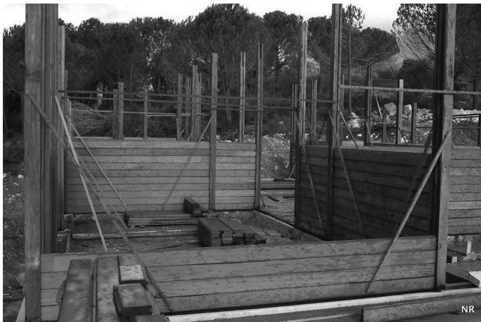
**Figura 10: Sistema construtivo do tipo pilar-viga e paredes macho-fêmea.**
