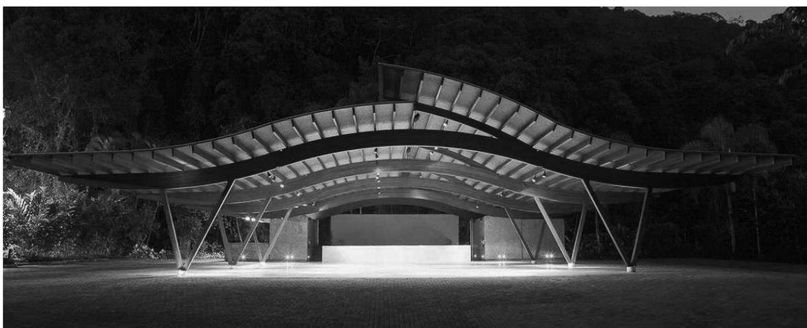
**Figura 13: Estrutura de Madeira Laminada Colada.**
