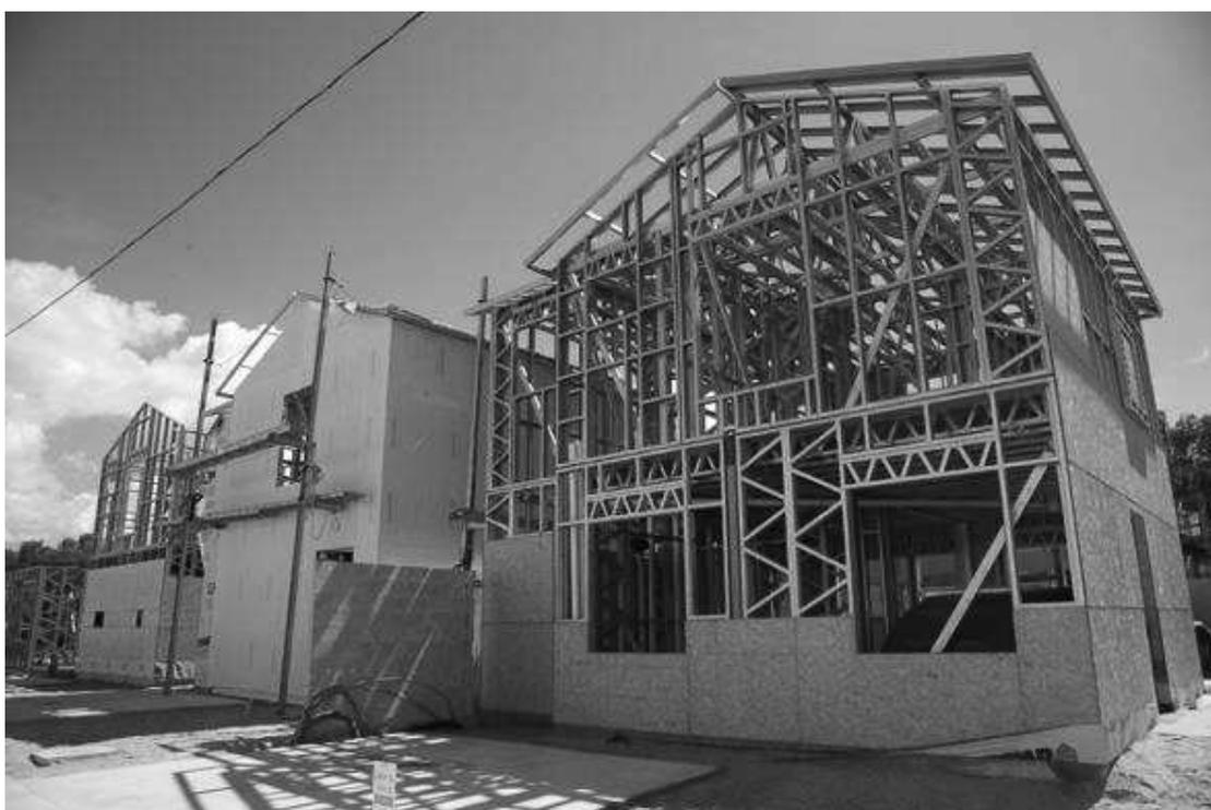
**Figura 14:** Edificação em *light steel frame*.
