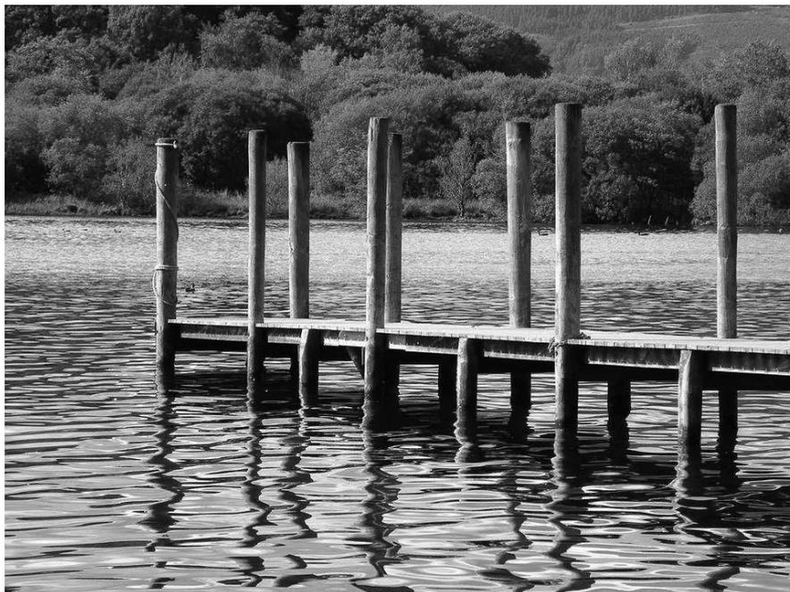
**Figura 4: Pier com fundação em estacas de madeira.**
