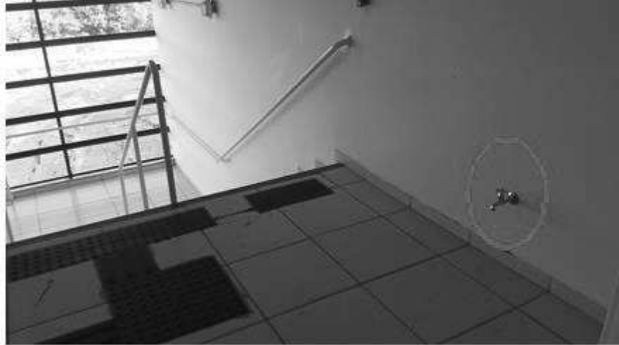
Figura 15: Ponto de consumo referente a prumada abastecida por água potável. Fonte: Autoria própria (2017).
