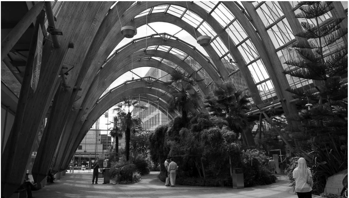
Figura 10 - Jardim de Inverno de Sheffield com cobertura feita com arcos de madeira laminada colada, em Sheffield, Inglaterra
