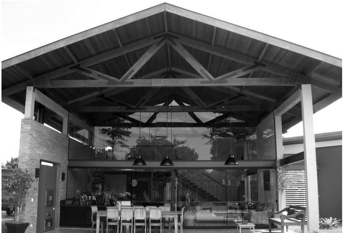
Figura 8 - Residência com tesouras de madeira
