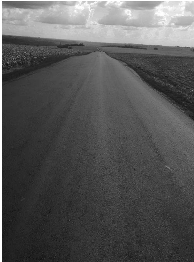
Figura 5 - Estrada com revestimento flexível betuminoso em Toledo-PR Fonte: Autor, 2017
