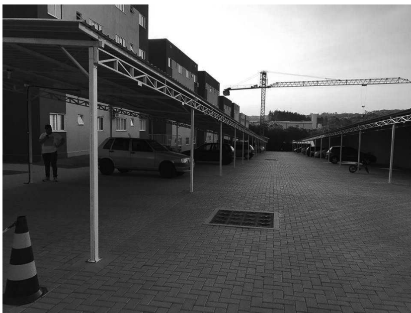
Figura 19 – Vista frontal do estacionamento do Residencial (1ª Fase)
