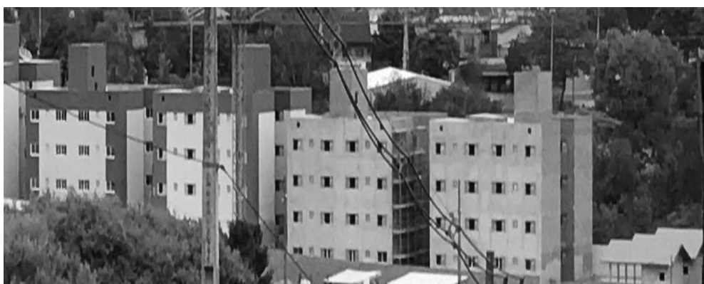
Figura 17 – Blocos 5,6,7 e 8 – em fase de construção
