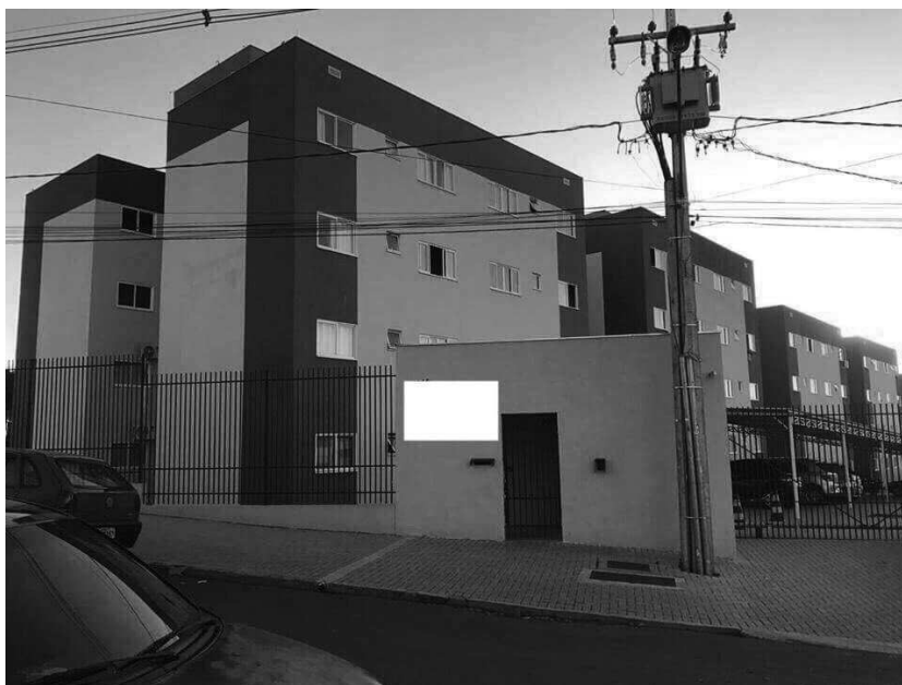
Figura 20 – Vista do “Residencial A” a partir da rua de acesso
