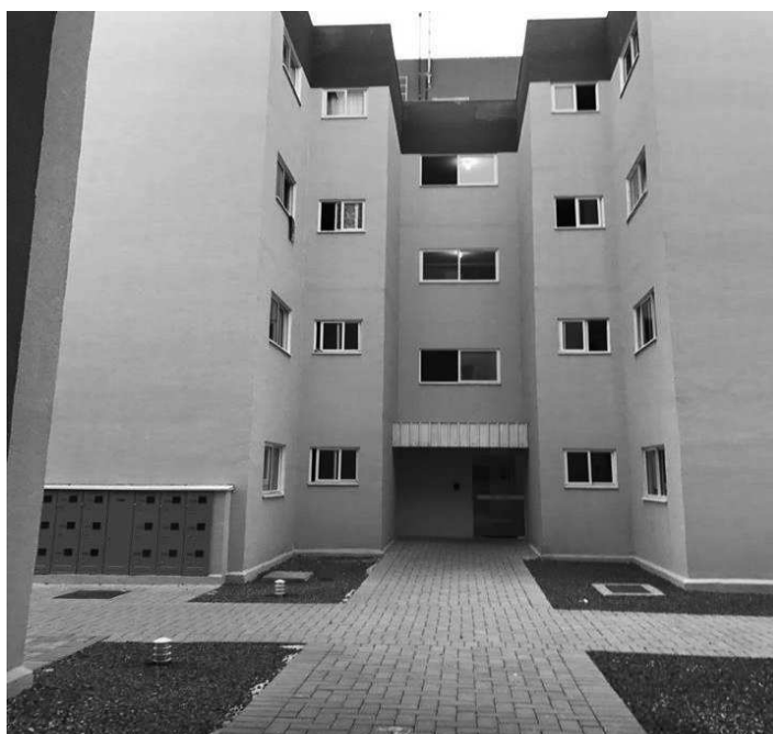
Figura 22 – Vista de um bloco do “Residencial A”
