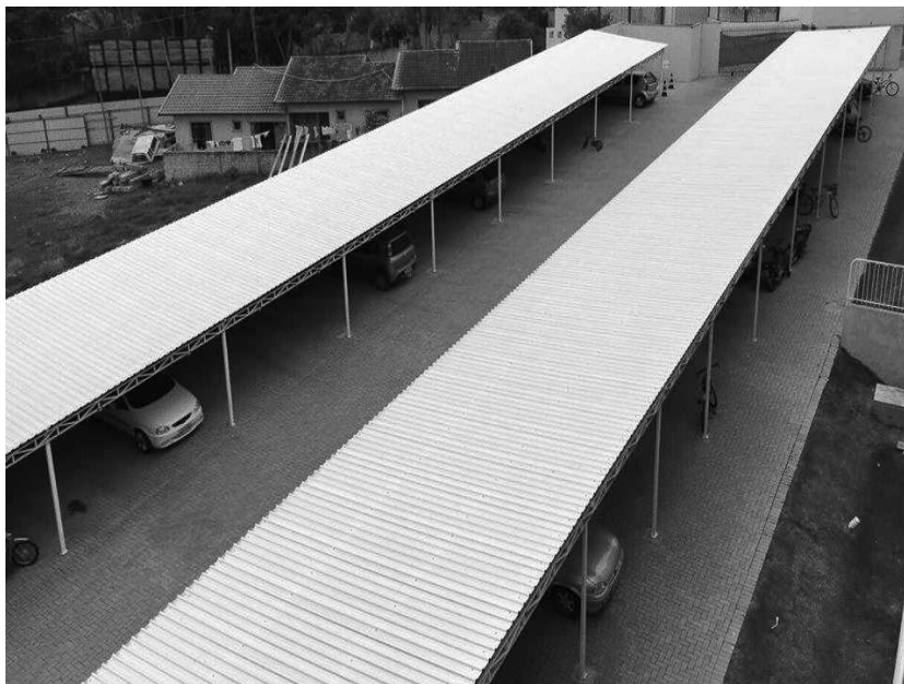
Figura 18 – Vista superior do estacionamento do Residencial (1ª Fase)
