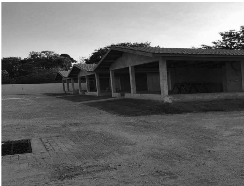
Figura 16 – Área de convivência comum e recreação – em fase de construção
