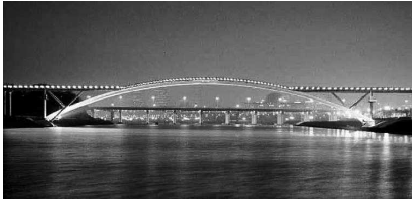
Figura 3 - Ponte de pedestres em Seoul, Coréia do Sul Fonte: Isaia, Helene e Tutikian (2011).
