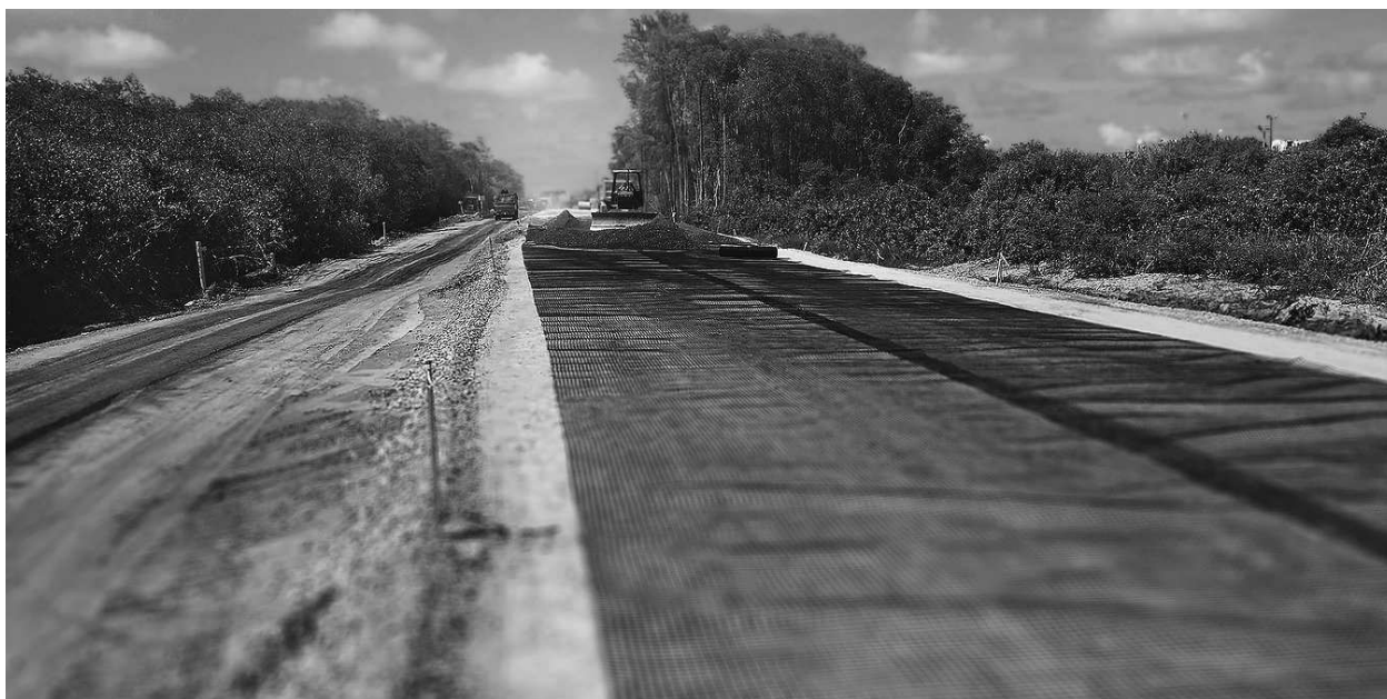
Figura 6 – Aplicação de geogrelha em estradas rurais Fonte: Manas Geo Tech India Pvt Ltd, 2016
