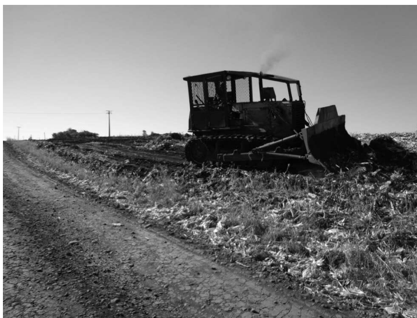
Figura 11 - Limpeza da área de regularização
