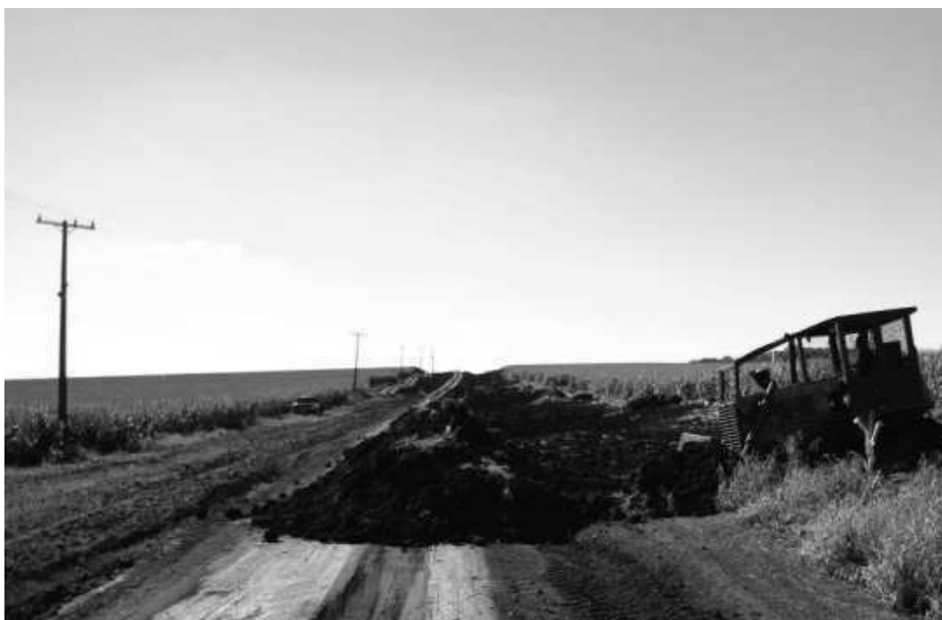
Figura 13 – Regularização dos taludes
