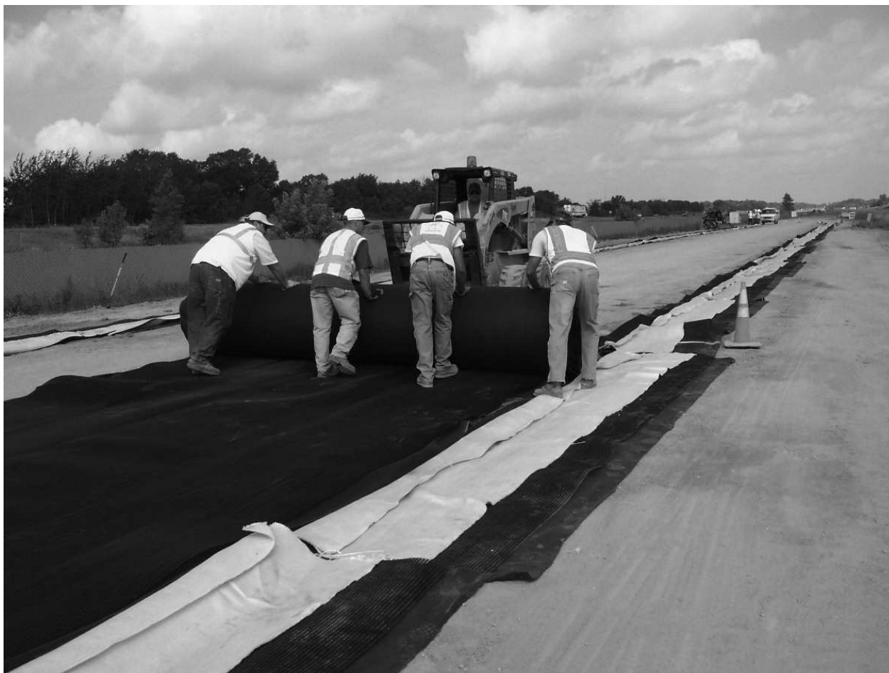
Figura 5 – Aplicação de manta geotêxtil em estradas Fonte: Geosoluções, 2016.
