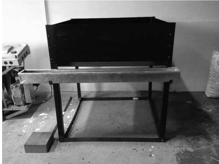
Figura 16: Instalação da calha junto às braçadeiras. Fonte: Autor (2016).
