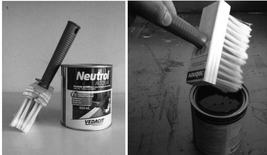
Figura 14: Aplicação da emulsão asfáltica nas chapas de aço. Fonte: Autor (2016).
