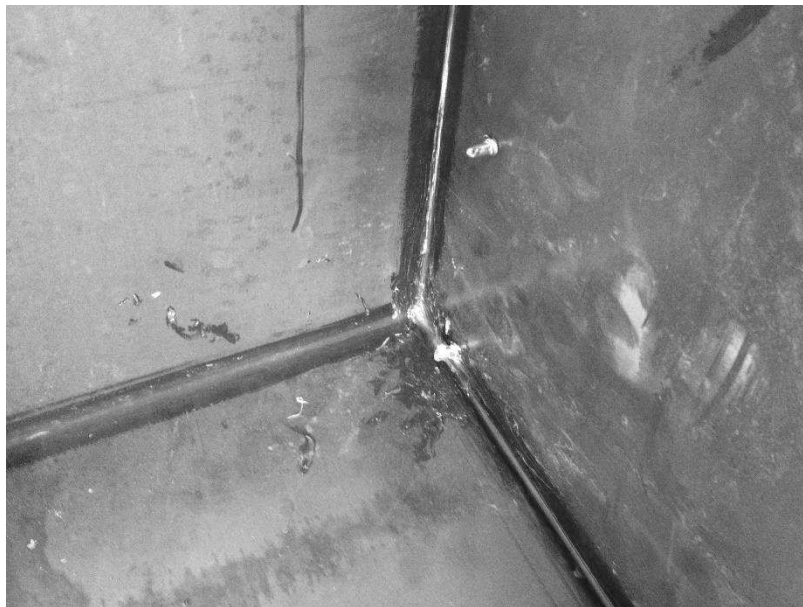
Figura 13: Resultado do acabamento final da aplicação do silicone. Fonte: Autor (2016).
