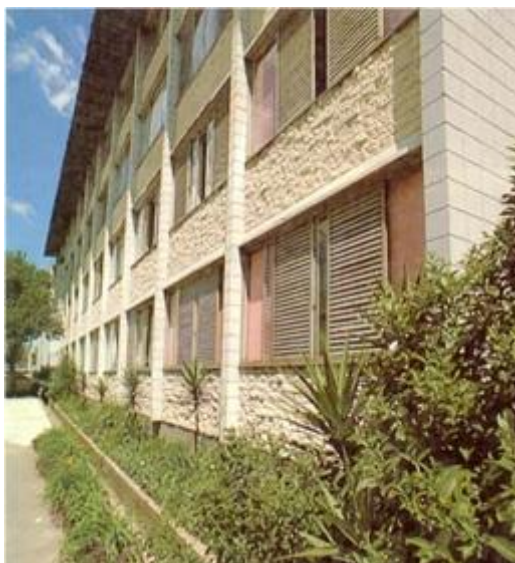
Figura 2 – Primeiro relato de construção em alvenaria estrutural do Brasil Fonte - RAMALHO E CORRÊA 2003
