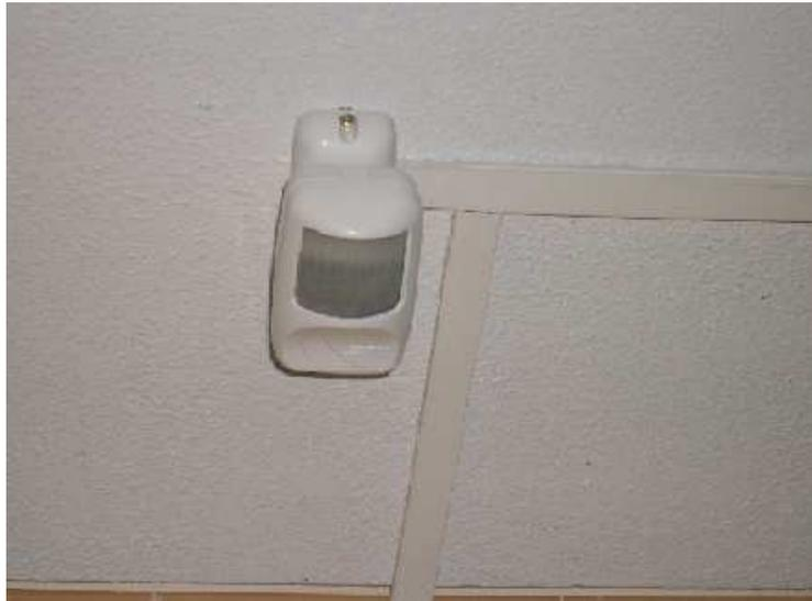
**Figura 23 - Instalação do sensor no teto do banheiro.**
