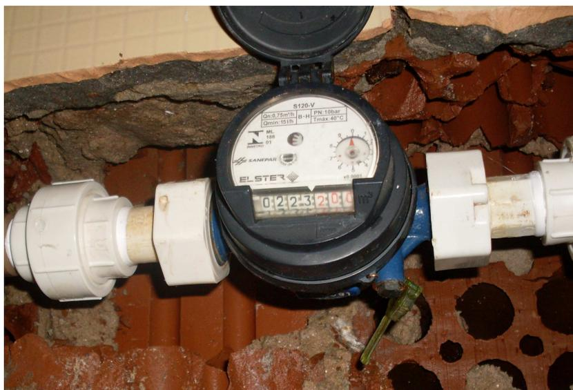
**Figura 18 - Leitura inicial após a instalação.**
