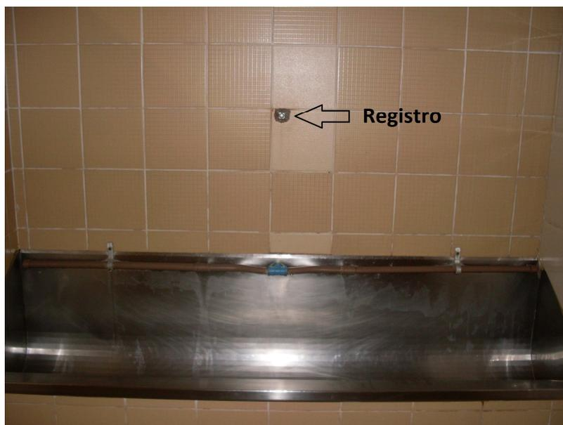
**Figura 15 – Local de instalação do registro.**
