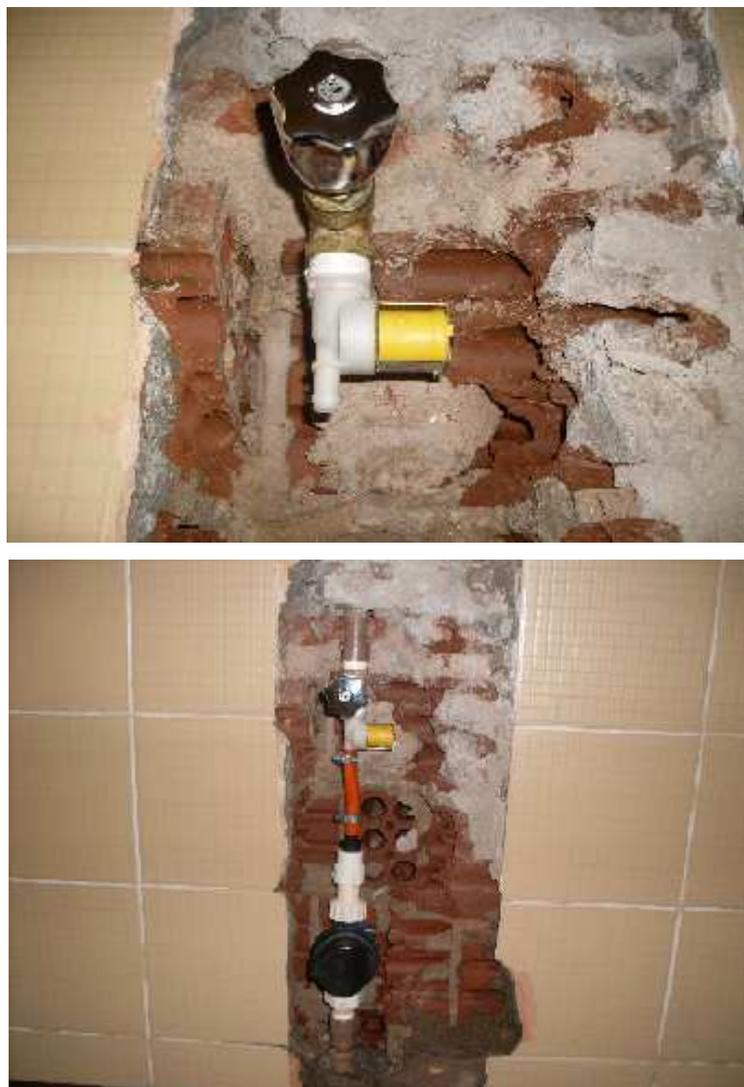
**Figura 22 - Válvula instalada.**
