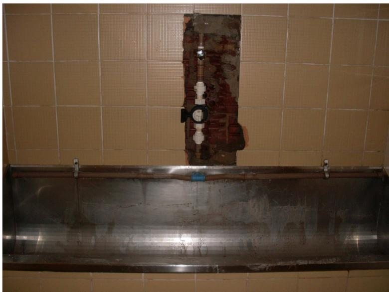
**Figura 17 - Instalação do hidrômetro**
