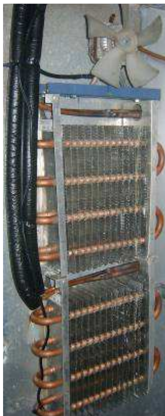
Figura 4: Trocadores de calor internos
