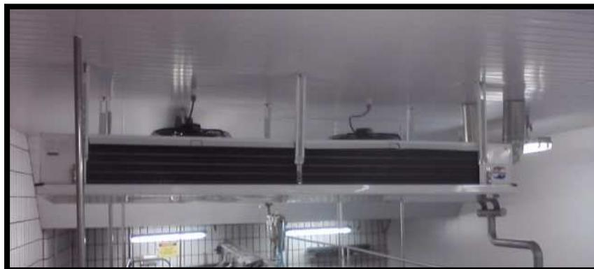
Figura 5- Evaporador da sala de embalagem primária
