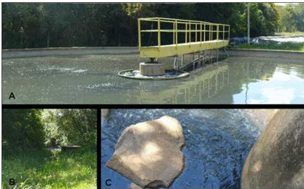
**Figura 8. Tratamento** Final da Parte Líquida: A) decantador Secundário, b) e c) liberação em corpo hídrico receptor do efluente tratado na ETE de Pato Branco, Paraná.
