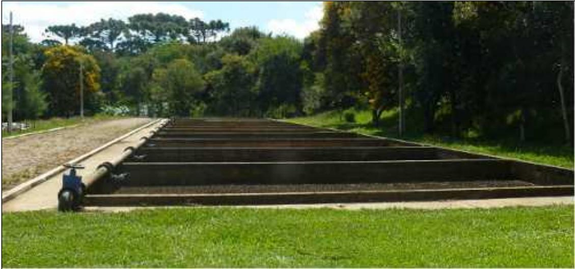
**Figura 9.** Leitos de Secagem de Lodo na ETE de Pato Branco, Paraná.
