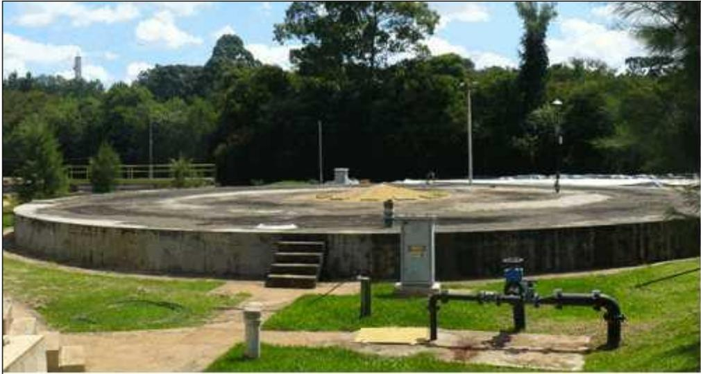
**Figura 7.** Reator Anaeróbio de Manto de Lodo e Fluxo Ascendente na ETE de Pato Branco, Paraná.
