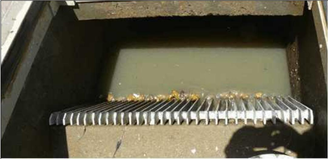
**Figura 5.** Gradeamento do Esgoto Bruto na ETE de Pato Branco, Paraná.
