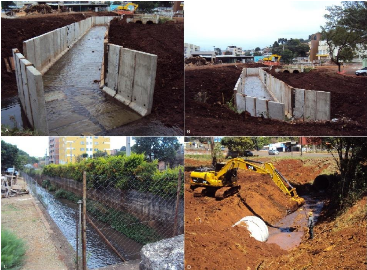
Figura 22 – Pontos de canalização do Córrego Fundo a) e b) Obras de canalização iniciadas em Fevereiro 2011 c) Canalização antiga existente d) Obra de canalização efetuada em 2010 Fonte: Autor
