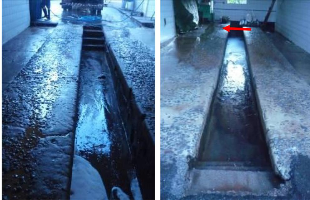
Figura 3 – Rampas de lavagem de veículos (Fonte: própria).
