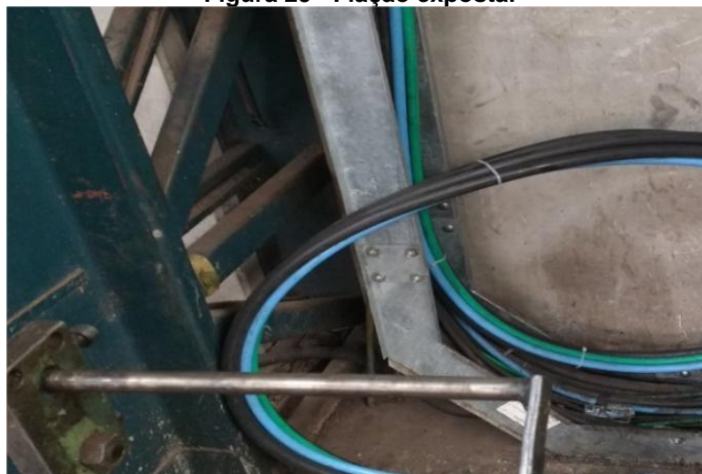
Figura 25 - Fiação exposta.
