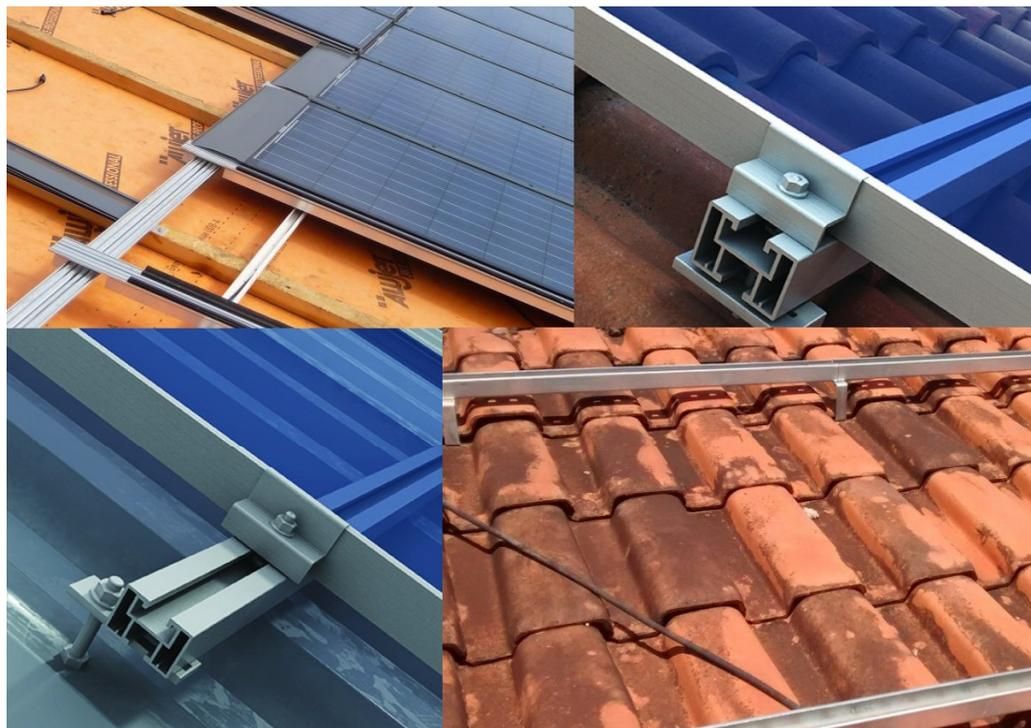
**Figura 22: Exemplo de estruturas de suporte e fixação de alumínio.**
