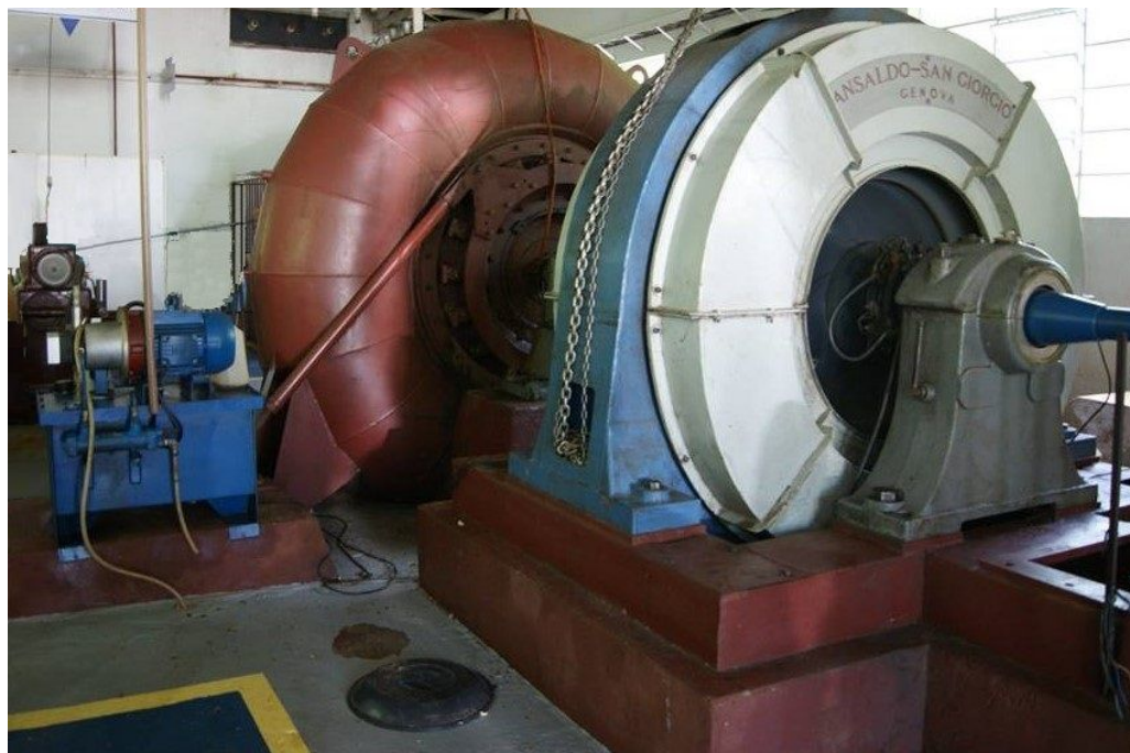
Figura 20: Gerador, turbina e regulador de velocidade da CGH Urio. Fonte: Autoria própria
