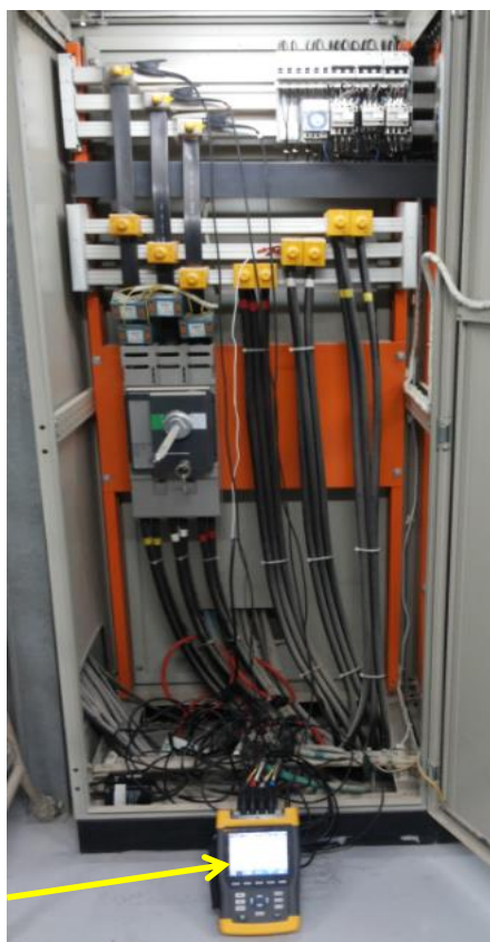
Figura 21 - Conexão do Analisador de Grandezas ao QD Principal Fonte: Autoria Própria
