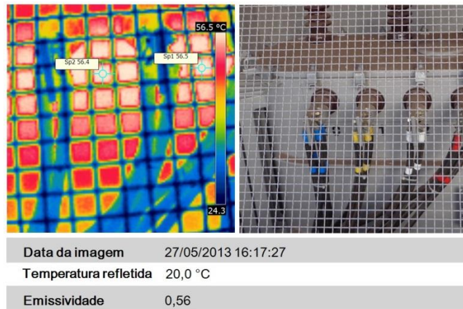
Figura 65 - Tanque (TR 4) Fonte: Autoria própria.
