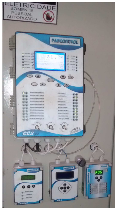
Figura 1: Típico painel de controle de um sistema de automação de aviário. Exemplo 1. Fotografia: Autoria própria.
