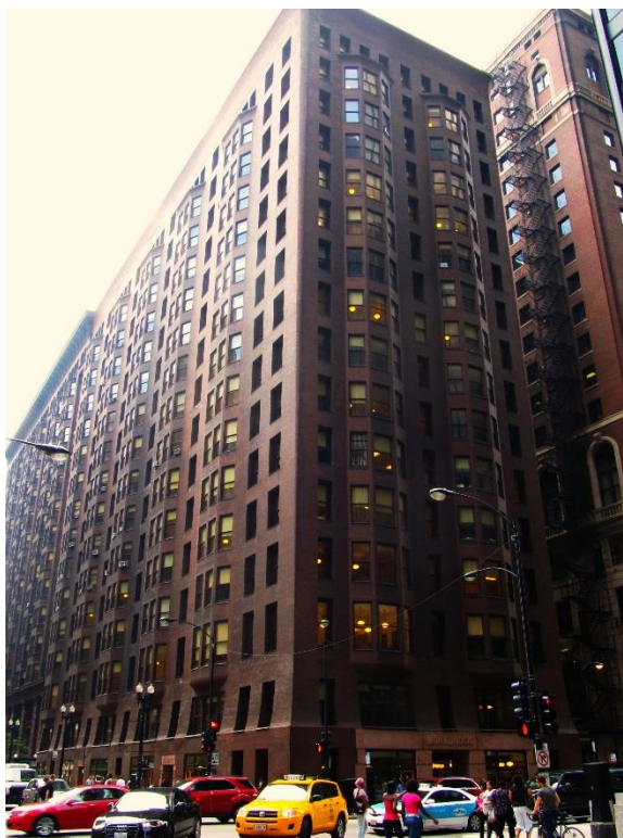
Figura 4 - Edifício Monadnock Fonte: Ken Lund, 2013
