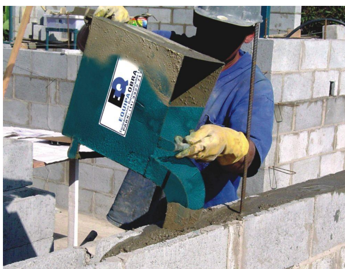
Figura 10 - Processo de grauteamento Fonte: EQUIPAOBRA – Catálogo, 2017
