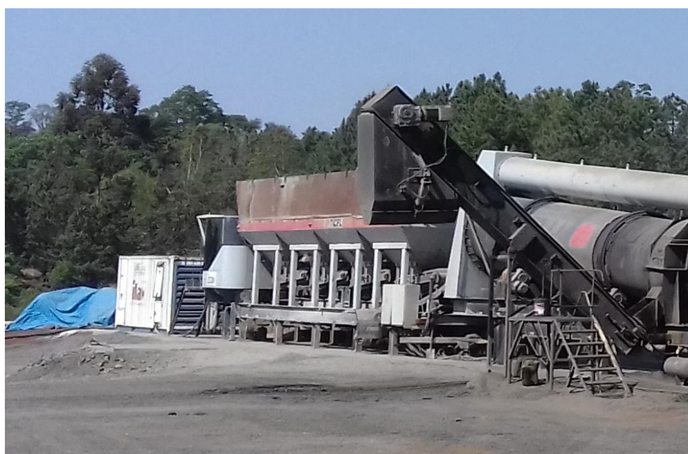
Figura 13: Reservatórios dosadores da usina de concreto asfáltico
