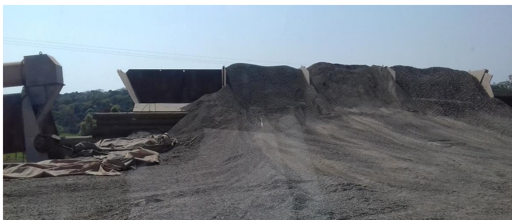
Figura 12: Estocagem de material na usina de concreto asfáltico
