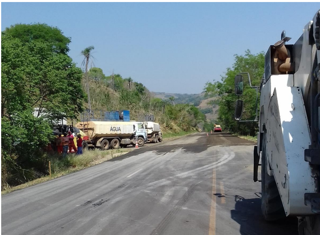
Figura 8: Trecho em que a reciclagem do pavimento com adição de cimento Portland estava sendo executada (pintura de imprimação)
