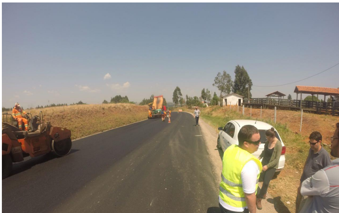
Figura 9: Trecho em que a reciclagem do pavimento com adição de cimento Portland estava sendo executada (compactação final do pavimento)
