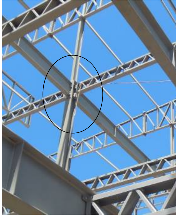
Figura 79: Emenda de pilar com perfis diferentes. Fonte: AUTOR (2015).
