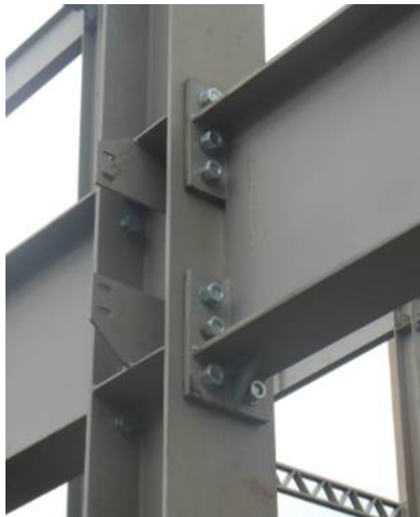
Figura 73: Ligação entre viga de alma cheia e mesa do pilar. Fonte: AUTOR (2015).
