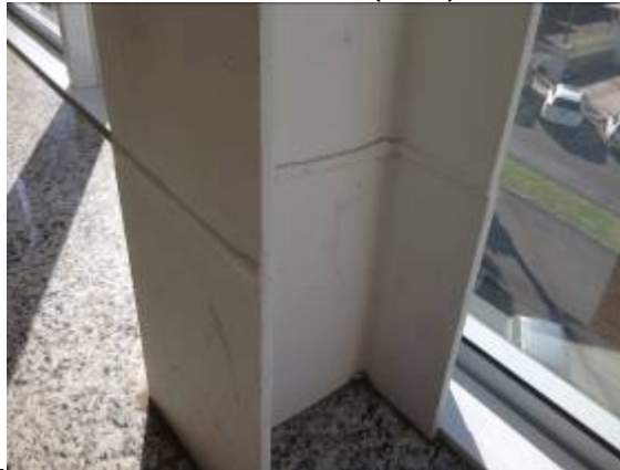
Figura 80: emenda de pilar com perfis diferentes. Fonte: AUTOR (2016).
