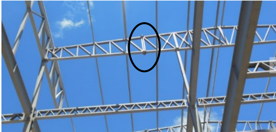
Figura 85: Emenda de Tesoura Fonte: AUTOR (2016).
