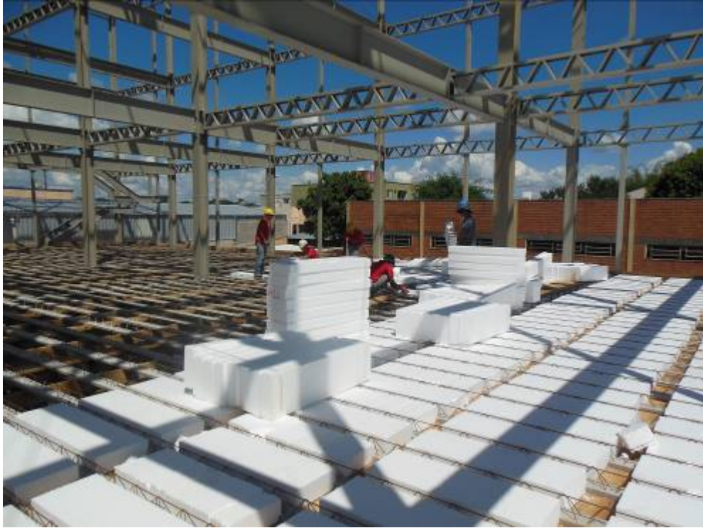
Figura 99: Instalação das lajes. Fonte: AUTOR (2015).
