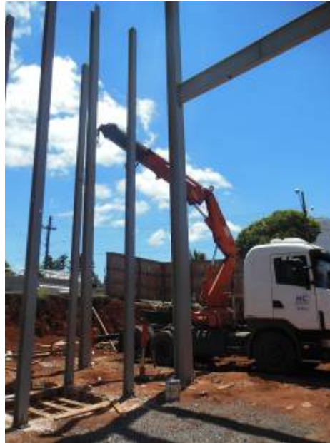
Figura 96: Içamento dos perfis I dos pilares. Fonte: AUTOR (2015).
