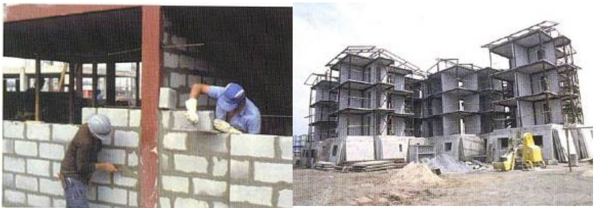
Figura 32: (a) Execução de alvenaria na estrutura metálica. (b) Montagem de painéis pré-moldados.
