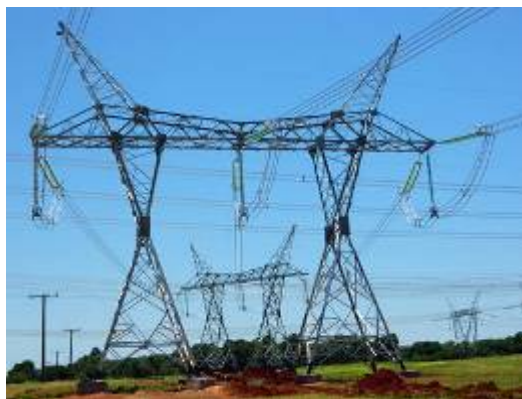
Figura 37: Estrutura metálica reticulada. Fonte: AGÊNCIA DE NOTÍCIAS (2016)
