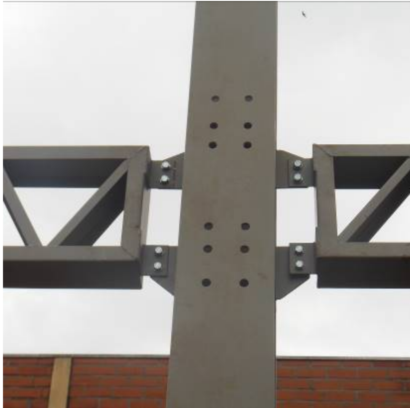
Figura 71: Ligação entre vigas treliçadas e os pilares. Fonte: AUTOR (2015).
