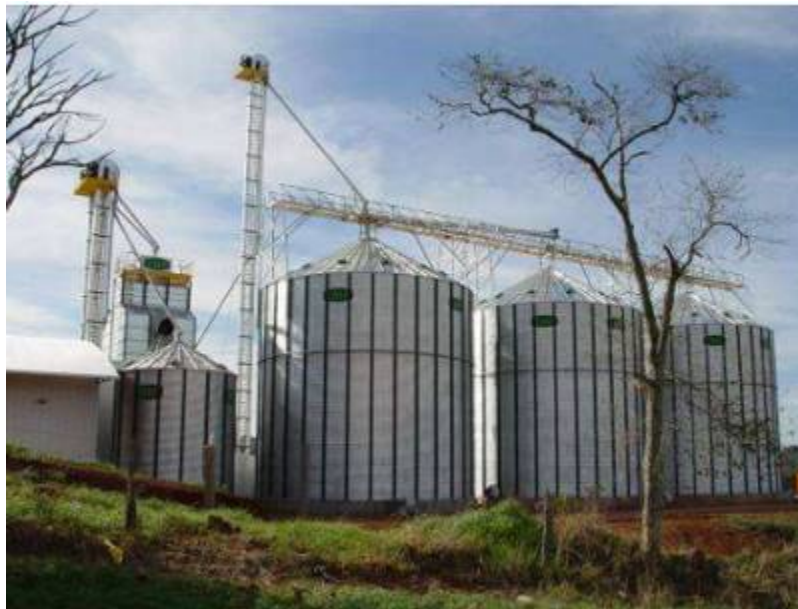
Figura 40: Silos de armazenamento Fonte: SCALABRIN (2008).
