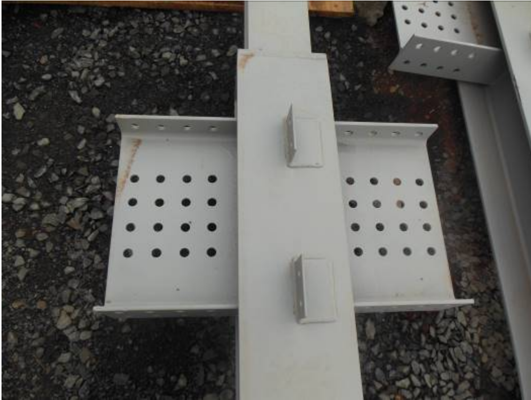
Figura 74: Pilar com placa de gousset. Fonte: AUTOR (2015).
