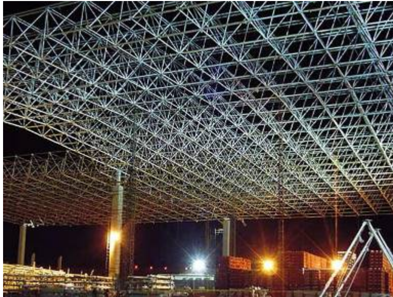
Figura 39: Estrutura espacial Fonte: METALFERRO (2015).
