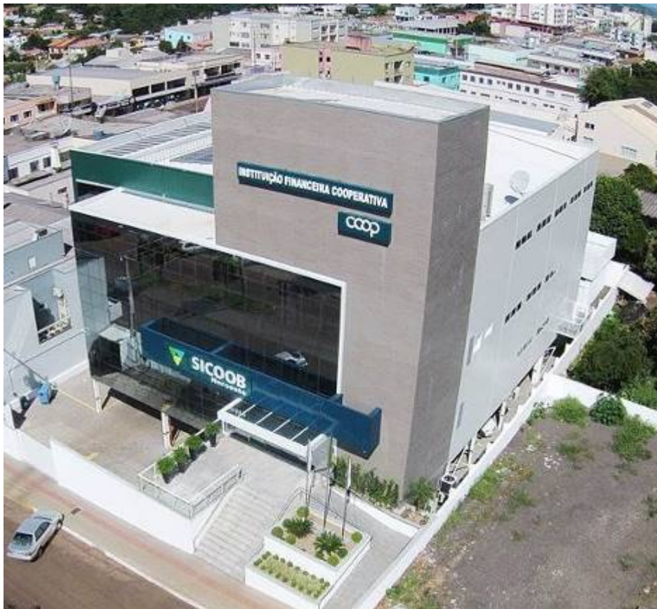
Figura 42: Edifício SICOOB Noroeste. Fonte: METALCON (2016).
