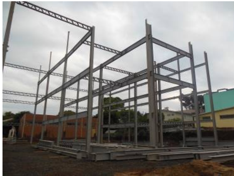
Figura 59: Estrutura SICOOB, fase inicial. Fonte: AUTOR (2015).
