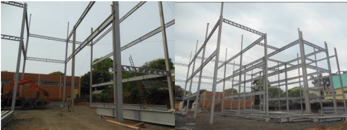
Figura 97: Fases de Montagem da estrutura metálica. Fonte: AUTOR (2015).
