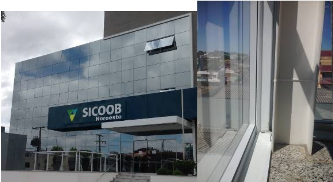
Figura 93: Cortina de vidro do edifício SICOOB (a) Detalhe da fachada. (b) Detalhe da instalação.
