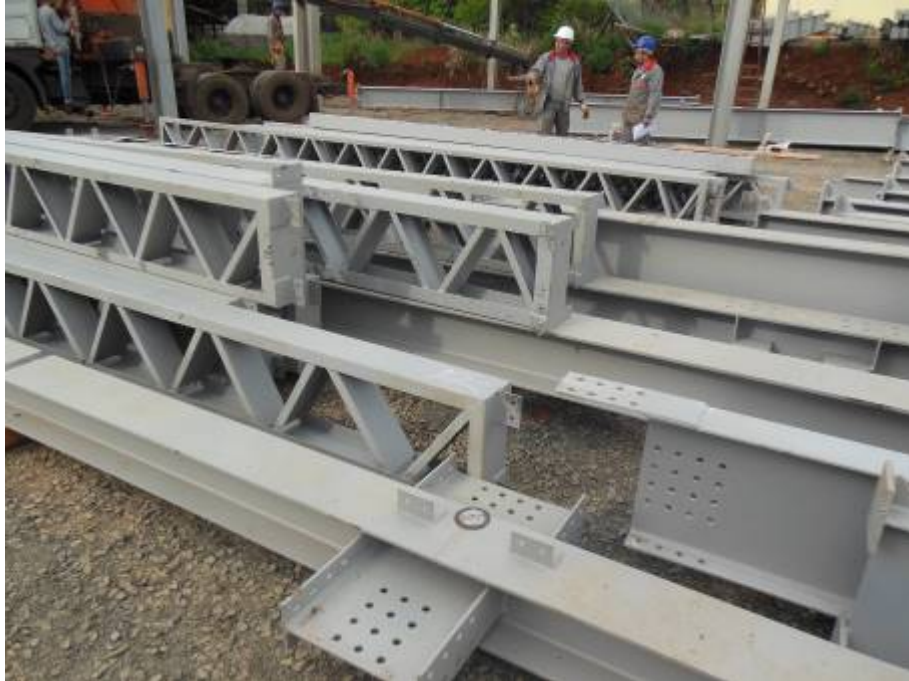
Figura 51: Vigas perfil I de alma cheia e vigas treliçadas do edifício SICOOB. Fonte: AUTOR (2015).
