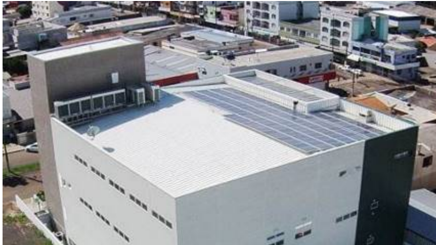
Figura 82: Cobertura do Edifício SICOOB. Fonte: METALCON (2016).
