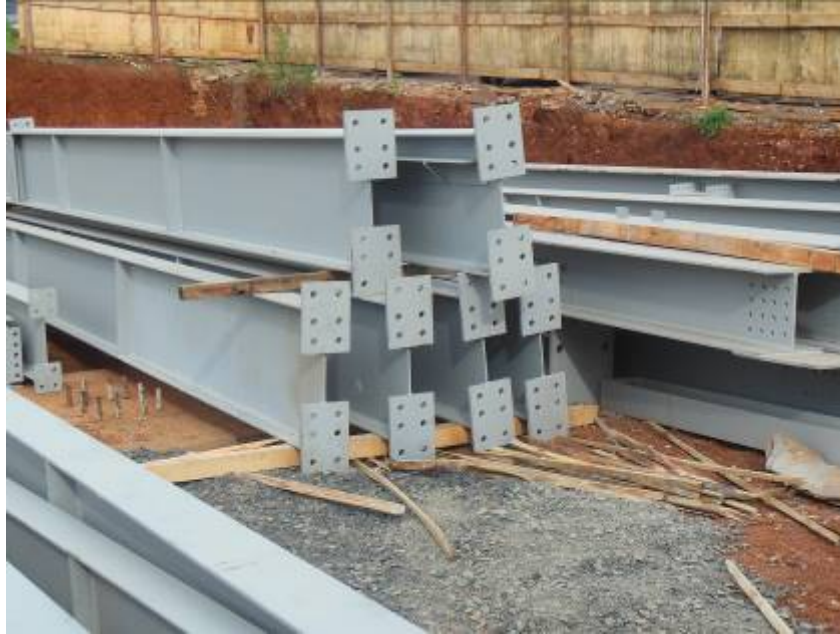
Figura 72: Vigas de alma cheia. Fonte: AUTOR (2015).
