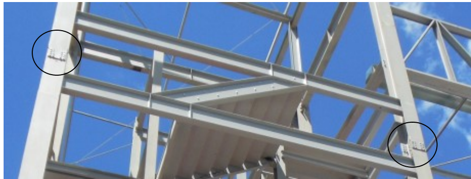
Figura 77: Emenda de pilares. Fonte: AUTOR (2015).
