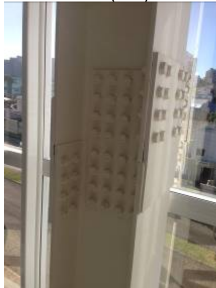
Figura 78: Emenda de pilares – SICOOB. Fonte: AUTOR (2016).
