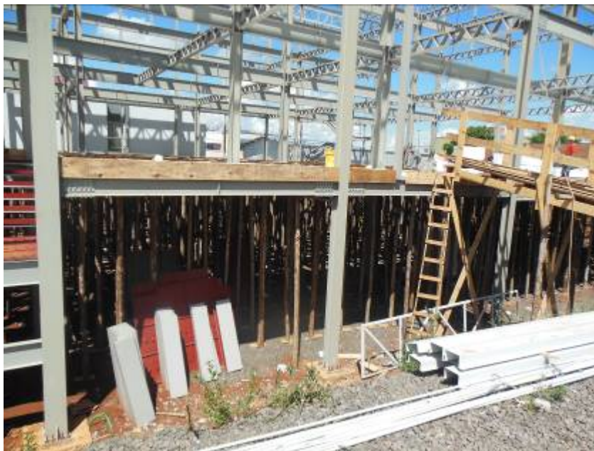
Figura 50: Escoramento da laje pré-moldada do edifício SICOOB. Fonte: AUTOR (2013).
