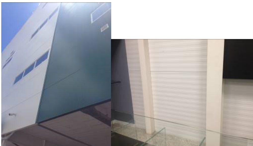
Figura 90: Painéis metálicos do edifício SICOOB. (a) Vista Externa (b) Vista Interna. Fonte: AUTOR (2015).
