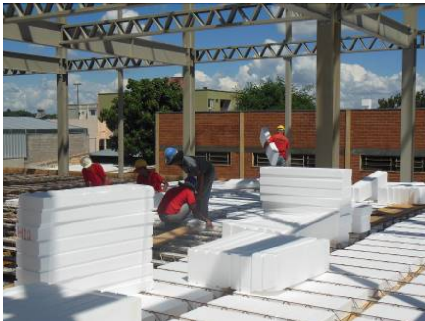
Figura 45: Laje treliçada edifício SICOOB. Fonte: AUTOR (2013).
