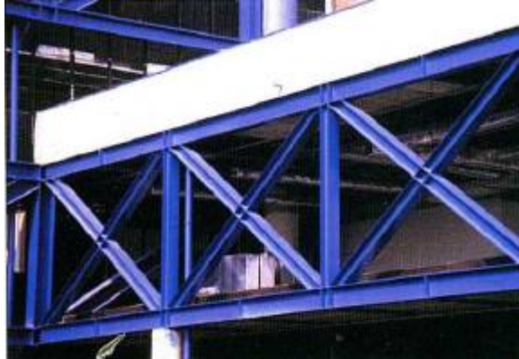
Figura 16: Viga treliçada. Fonte: DIAS (1998).
