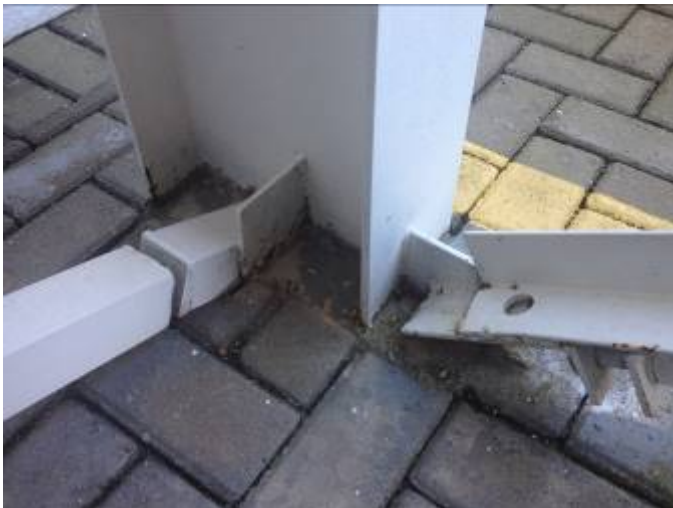
Figura 95: Fixação do contraventamento. Fonte: AUTOR (2016).
