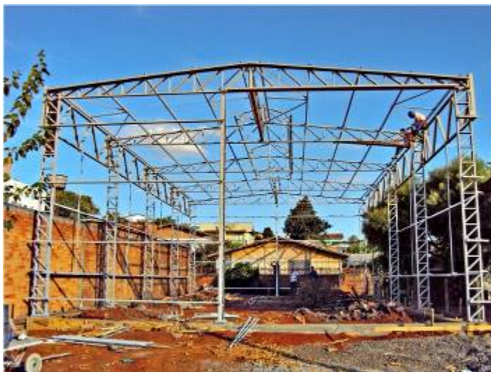
Figura 35: Estrutura de Galpão em aço. Fonte: METALCON (2015).
