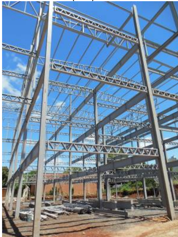
Figura 52: Vigas perfil I de alma cheia e perfis treliçados do edifício SICOOB. Fonte: AUTOR (2015).
